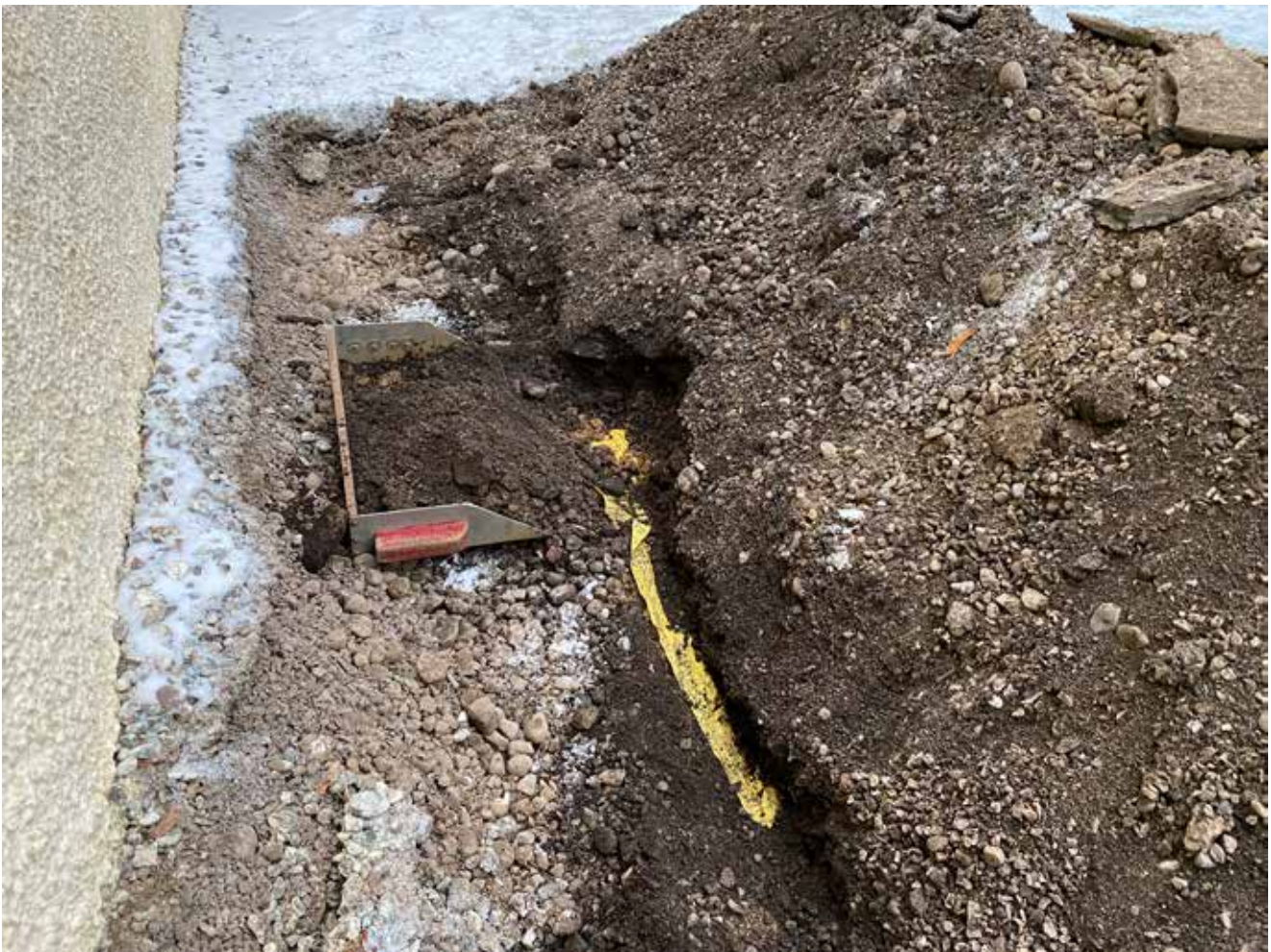
Figur 3. Här ses fyllningen i schaktet samt det gula plastbandet som visar en elkabel.
