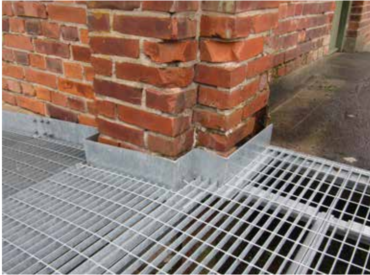
Rampen följer fasadens form, men är helt fristående och saknar helt infästning mot byggnadens sockel.
