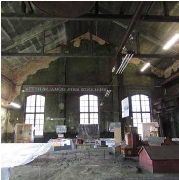
Museets väggar efter utförd rengöring. Väggarna dammsögs varsamt med ett munstycke med mjuk borst.
