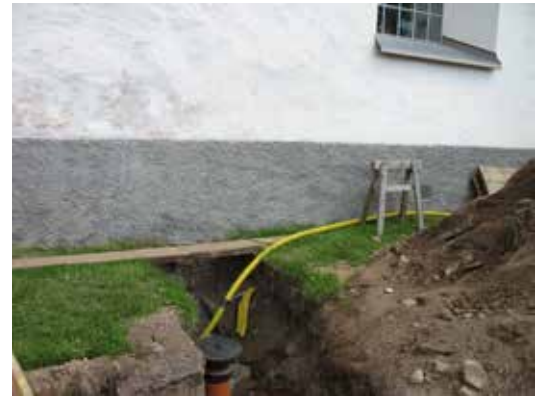
Genomföringen genom kyrkans yttervägg.
