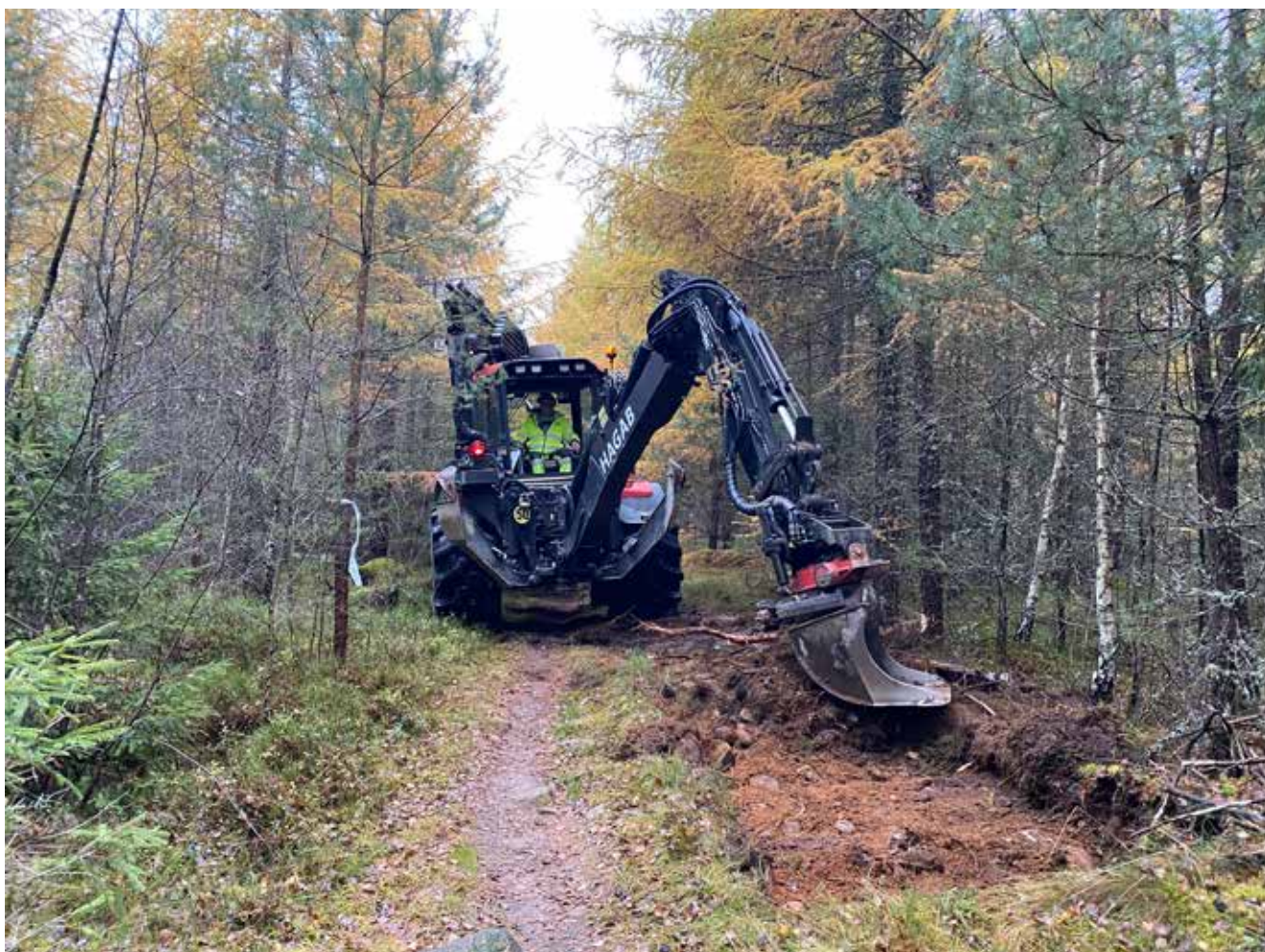
Figur 4. Arbetsbild. Sökschaktning utmed motionsspåret.
