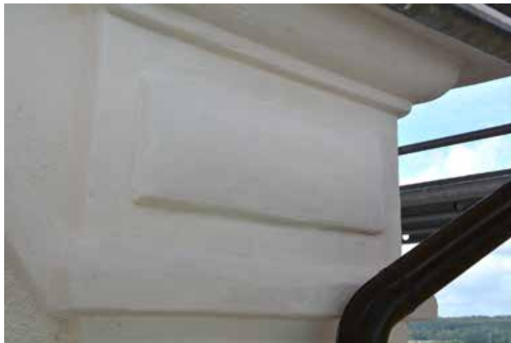
Den omputsade och avfärgade fasaden. En av de förkroppade puts dekorationerna i anslutning till taklisten och de slätputsade hörnomfattningarna. Fotografi från delbesiktning från ställning den 19 augusti.
