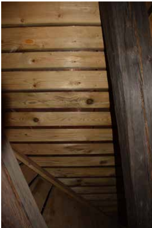
År 1996–97 lades den nedre delen av torntaket om, då byttes även panelen i takkonstruktionen. Den nya panel lades med distans mellan respektive bräda.
