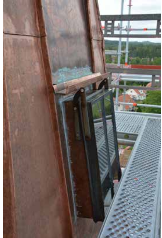
Takfönstret har fått ny inklädning samt en dropplist.
