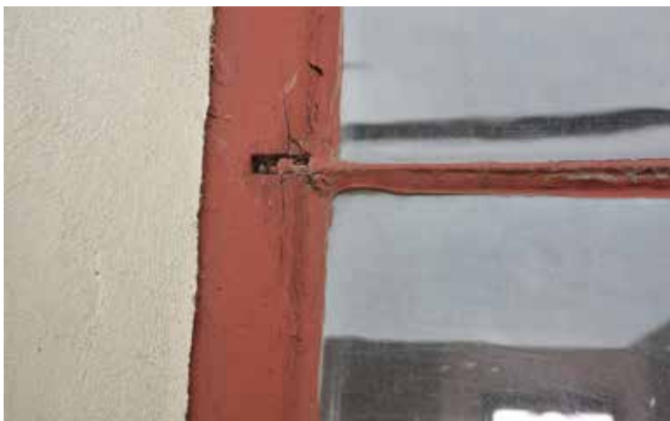
Ett av tornfönstren före åtgärd.
