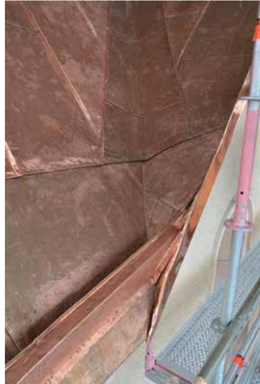
Nya ståndrännor sedda från sidan.
