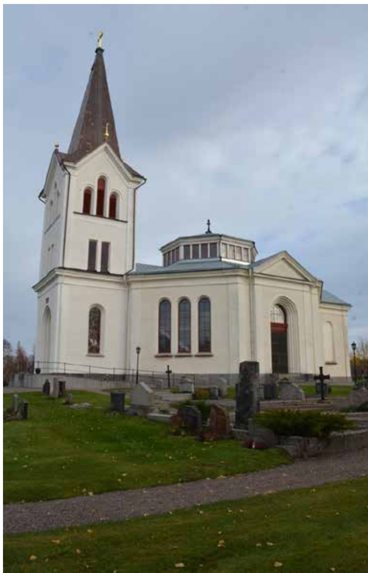
Kyrkan från söder, slutbesiktning.
