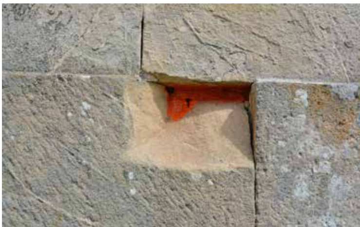
En järnklammer som är behandlad med blymönja.
