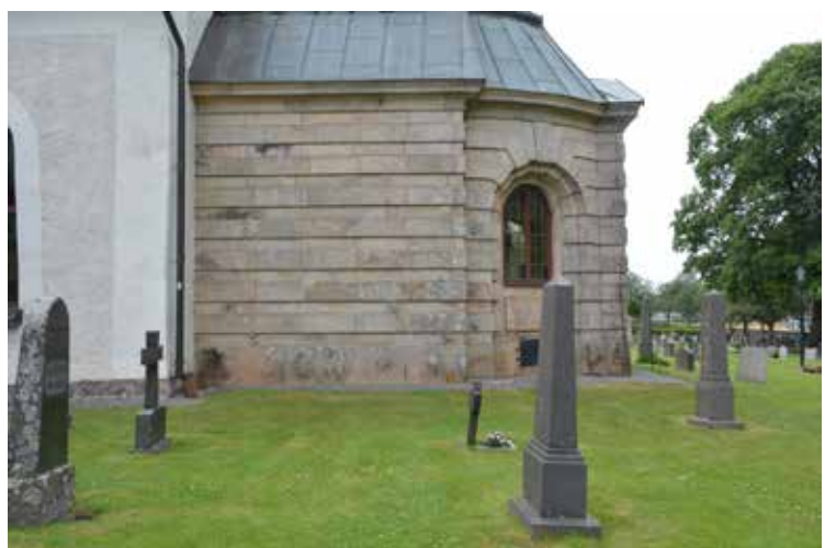
Översikt södra fasaden, lagningar och partier av fogarna har patinerats.
