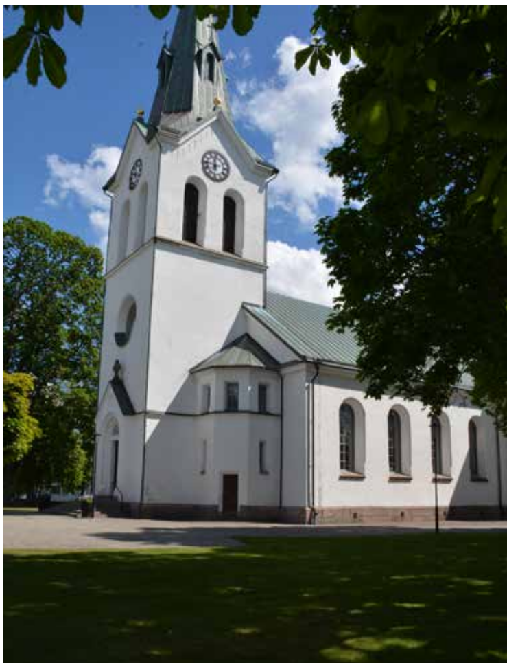
Värnamo kyrka från sydväst före åtgärd, foto juni 2020.
