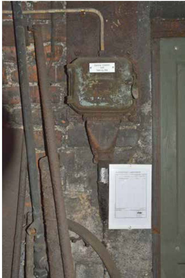
Skylten i kärnakeriet tillhör en av dem som föreslogs flyttas och monteras inne i elskåpet.
