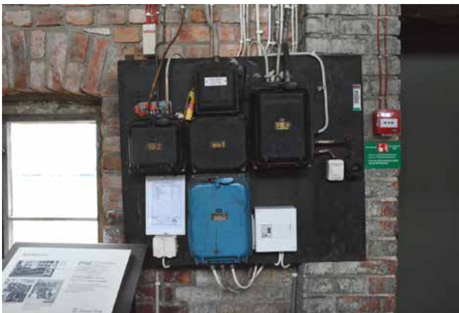
Vid elcentralen på modellvinden installerades en jordfelsbrytare.
