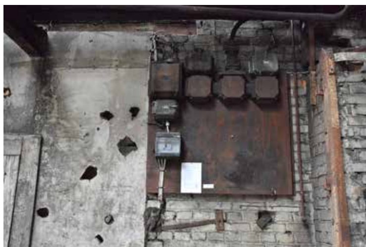
Enstaka nya skyltar upplevdes något iögonfallande, här i gjuteriet.
