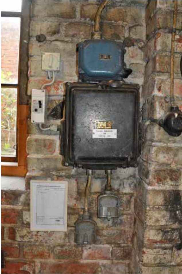
En av de mindre centralerna i den f.d. mekaniska verkstaden.
