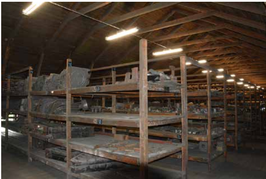
På modellagret hade lysrören bestyckats med ledlysrör på prov.
