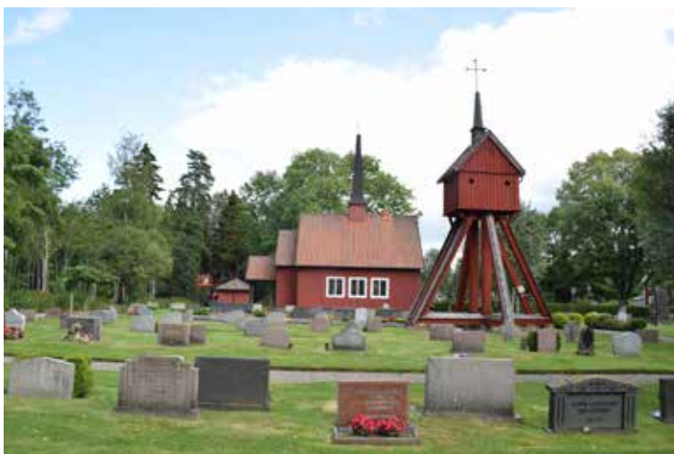
Kapellet och klockstapeln från väster, före åtgärd.
