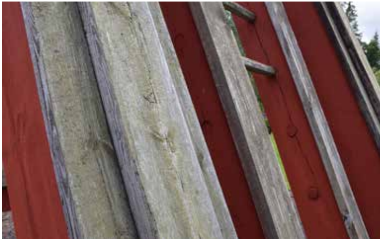
Klockstapelns täckbrädor var i behov av tjärning.
