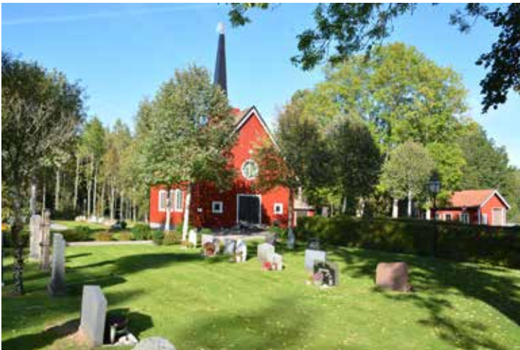
Kapellet och ekonomibyggnaden, översikt från sydväst.
