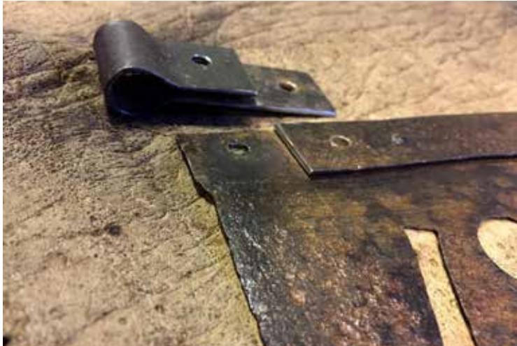
Det skadade övre svepet byttes ut. Foto Roland Svensson.
