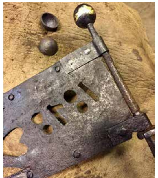
Vindflöjeln från 1818 efter utförda lagningar. Foto Roland Svensson.
