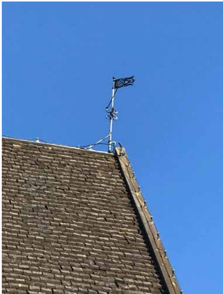
Den rekonstruerade vindflöjeln vid korgaveln. Foto Elmer Franzén, T. Ljungdahl byggnadsvård.
