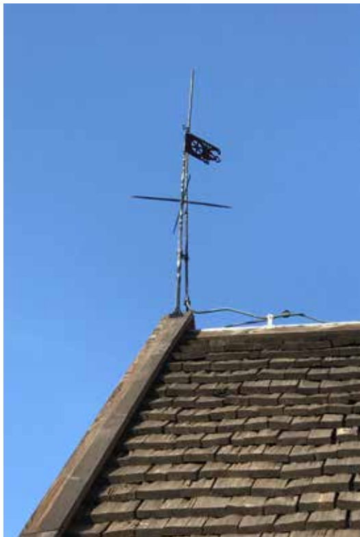
Den restaurerade flöjeln från 1689 på vapenhustaket .Foto Elmer Franzén, T. Ljungdahl byggnadsvård.
