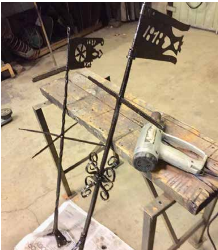
De äldre vindflöjlarna efter målningsbehandling. Foto Roland Svensson.
