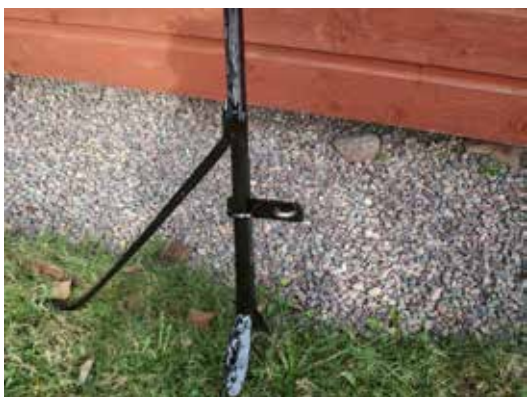
Fästdonen specialtillverkades av Stenssjöns smedja och målades med svart linoljefärg.
