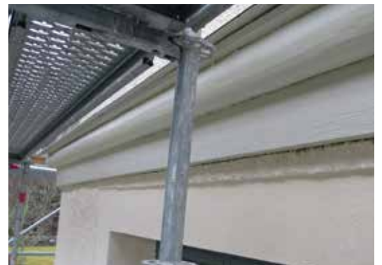
Sakristians trägesims målades i fasadens kulör.
