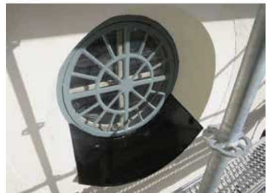
Rundfönster i västra gaveln efter ommålning.
