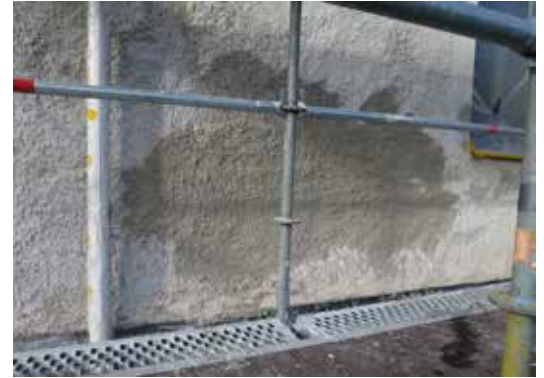
Putslagning på långskeppets södra fasad.
