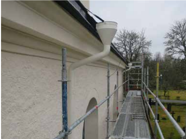
Långskeppet efter avfärgning samt målning av stuprör och plåttak.
