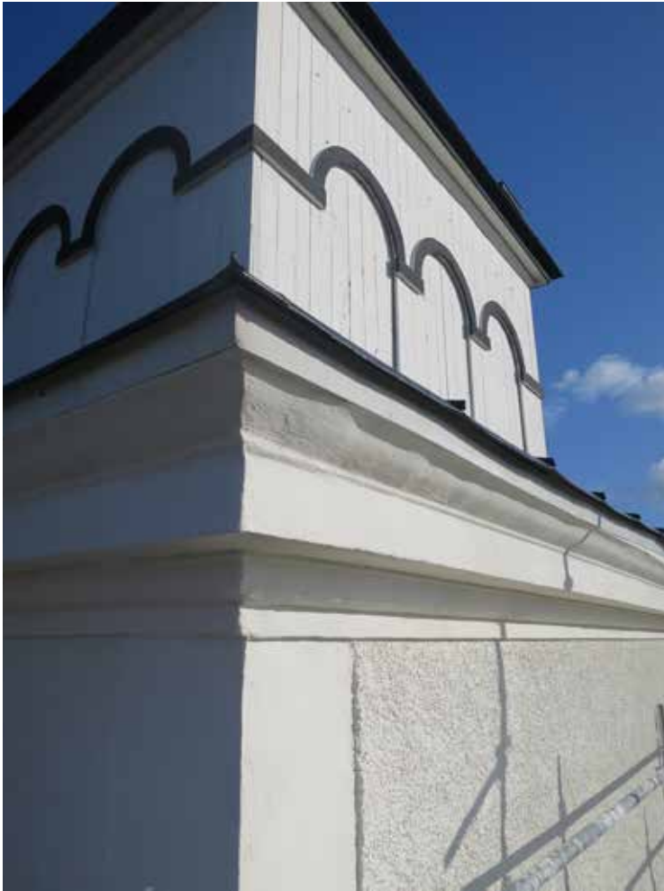
Tornets översta del efter putslagning, avfärgning och målning av tornaket. Lanterninen hade renoverats 2010.
