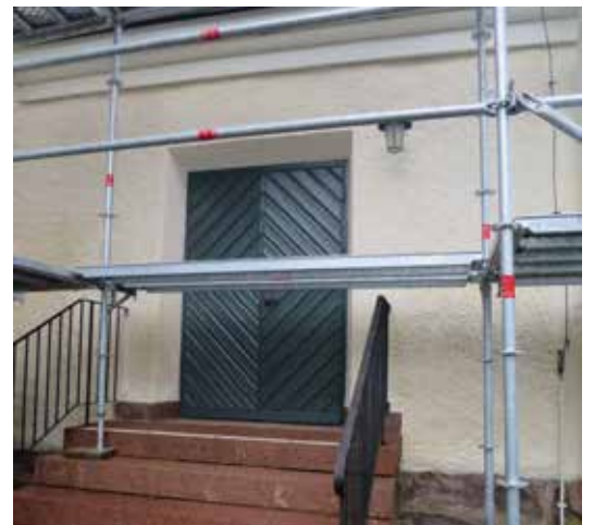
Kulören på sakristians dörr och sydporten ändrades till dalablått. Sidorna på trappan putsades om.
