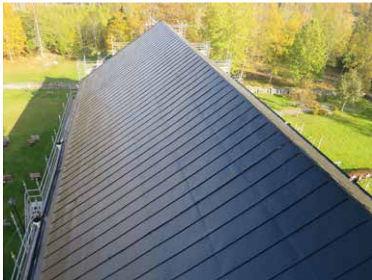
Långskeppets plåttak efter genomförd ommålning.
