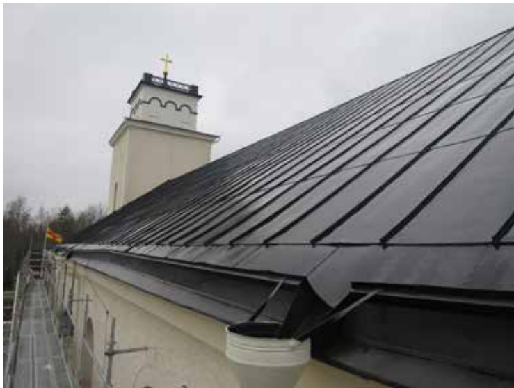
Långskeppets tak efter ommålning.
