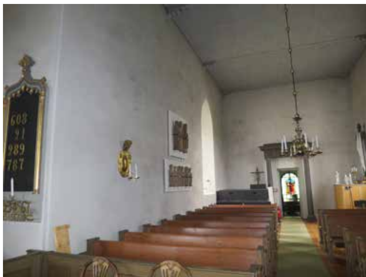
Östra korsarmen före ommålning.
