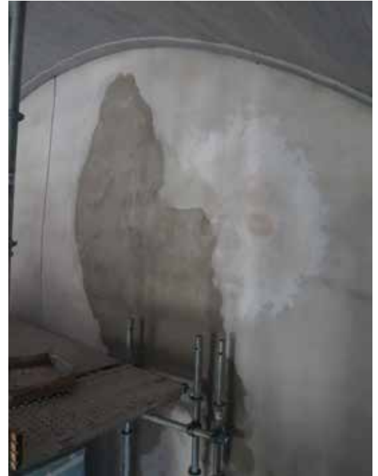
Lagning av större bomskada i norra gaveln delvis bakom orgeln.
