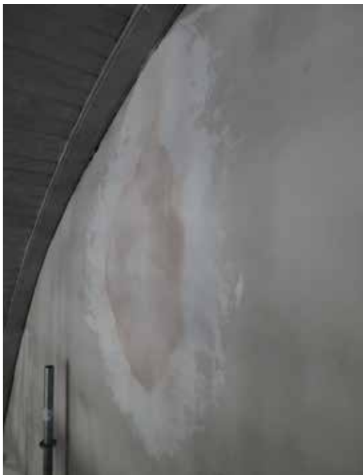
Putslagning på huvudskeppets norra gavel.
