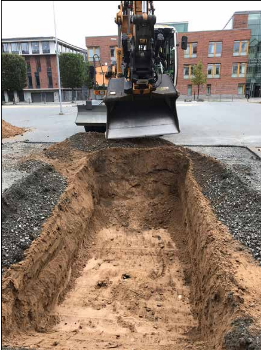
Figur 6. Schakt 10 med endast fyllnadsmassor från rivningen av lasarettet. Foto från väster.
