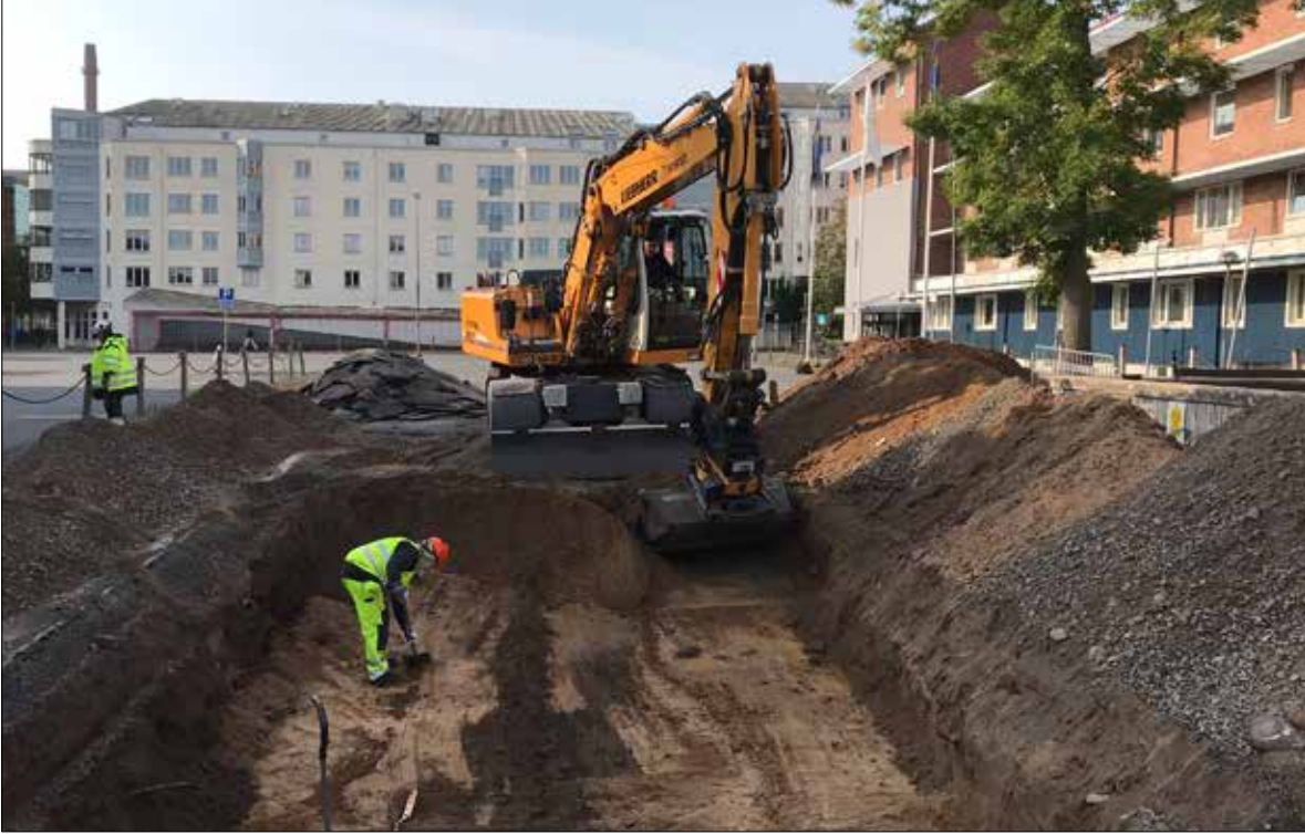
Figur 4. Här syns schakt 1 med den äldre marknivån som håller på att rensas fram. Foto från norr.
