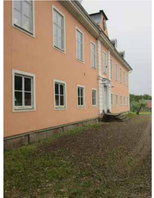
Huvudbyggnadens entréfasad där bottenvåningens lägre fönster är bevarade.
