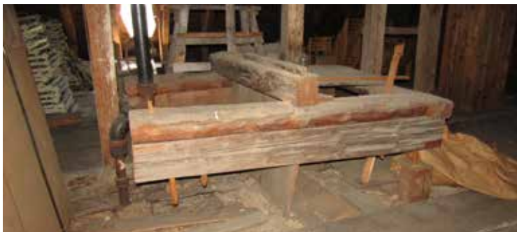
Denna timmerkonstruktion är bevarad vid ett av lägena för de tidigare skorstenarna och torde vara en del av konstruktionen med storstensstockar som inte var murade från marknivån.
