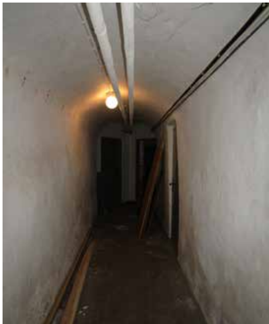
Ovan: Mittkorridoren i källaren.
