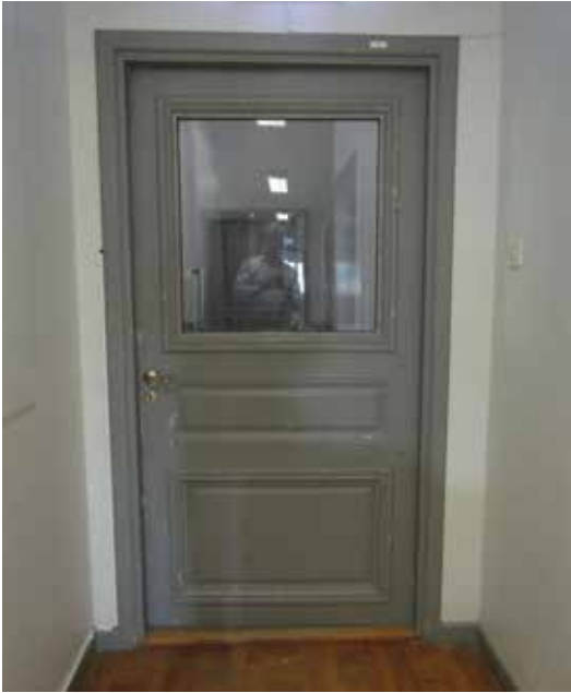
Ovan: Övre hallen (rum 201) med glasad äldre dörr. Nedan: Sentida dörr i äldre läge.
