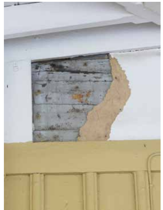
Ovan: Partiet över dörren med bubblig masonite. Nedan: Bakom masoniten fanns timret som var gråmålat.
