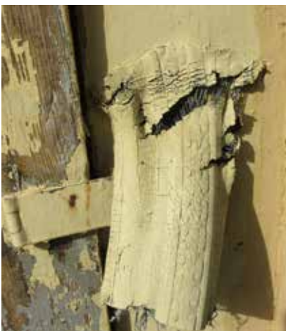
Skrapprov vid locklist: ljusgrå med blått inslag.
