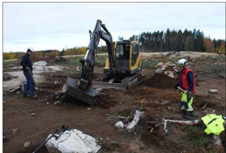
Figur 2. I samband med den andra avbaningen grävdes även kvarstående stubbar bort för att säkerställa att föremål eller anläggningar inte fanns under dessa.
