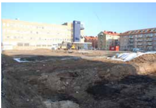
Figur 7. Undersökningsytan fotograferad från det sydöstra hörnet. Närmast i bild en yta som schaktats ner till botten och sedan olika nivåer av ytor och lager som väntar på analys avseende kontaminering.
