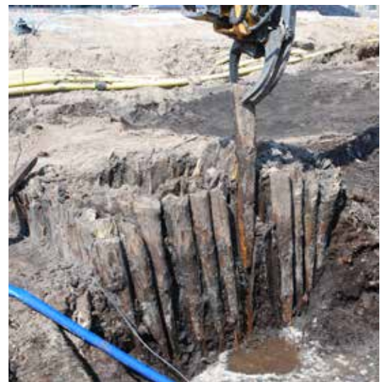
Figur 27. Stock för dendrokronologisk datering tas upp med grävmaskin.
