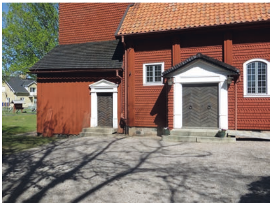
Delar av tornets och långhusets södra fasad med spånåtor som lagts om.
