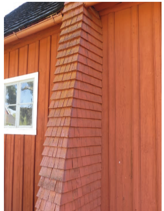
Ovan: Byte av spån på snedsträvan pågår. Till vänster: Det nedersta spånpartiet på tornet inför omläggningen. Här var rötskadorna mer begränsade. Nedan: Snedsträvan efter spånbyte, rödfärgning och rödtjärning.
