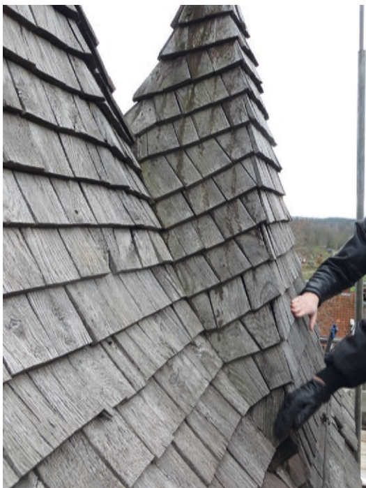
Ovan: Turellernas spånradar var inte horisontella inför omläggningen och detta ändrades när de nya spånen lades.
