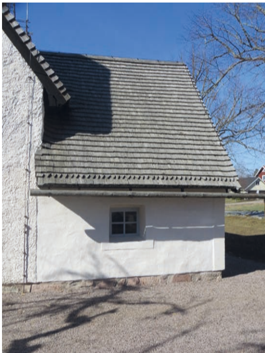
Ovan: Sakristians tak var omlagt tämligen nyligen och läggningssättet med rakavslutade spån med undantag för den näst nedersta raden nyttjades även nu. Ovan till höger: Haurida kyrka 1947. ATA.
