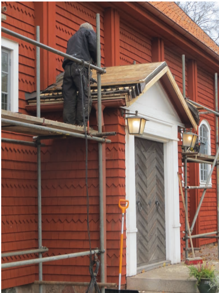
Ovan: Omläggning pågår på den nedtill avslutande delen av tornets övre parti.
