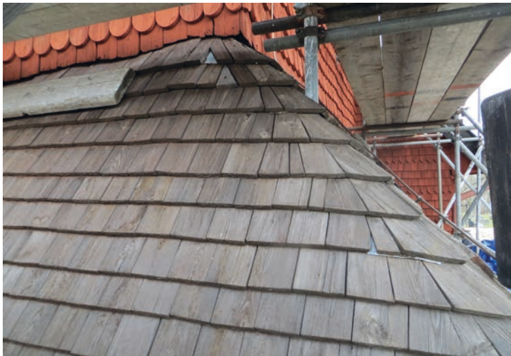
Ovan: Byte av spån på snedsträvan pågår. Till vänster: Det nedersta spånpartiet på tornet inför omläggningen. Här var rötskadorna mer begränsade. Nedan: Snedsträvan efter spånbyte, rödfärgning och rödtjärning.
