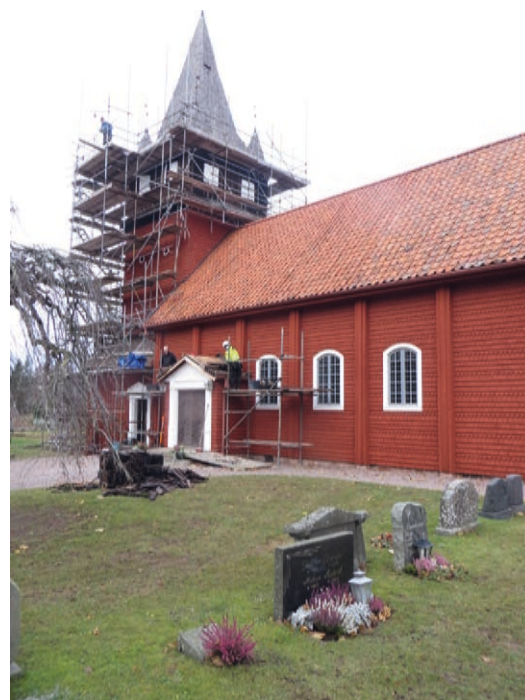
Haurida kyrka i samband med att arbetena startade i november 2018.
