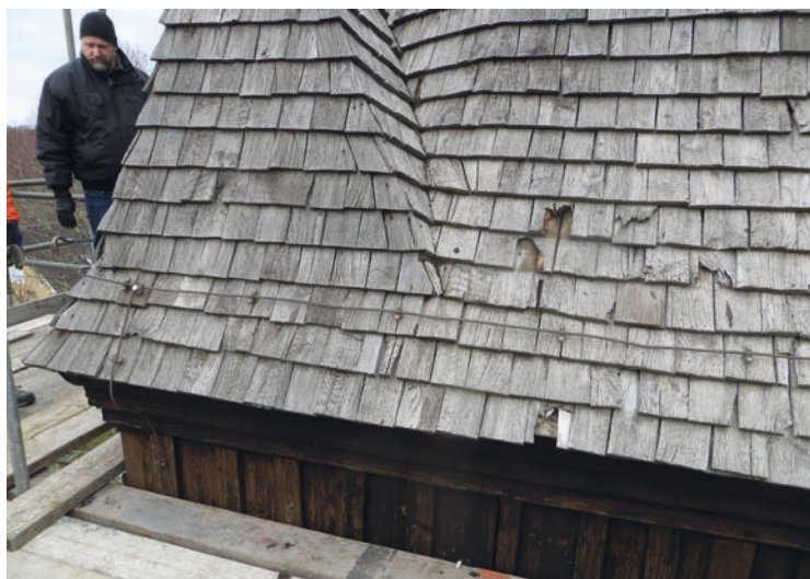
Ovan: Turellernas spånradar var inte horisontella inför omläggningen och detta ändrades när de nya spånen lades.
