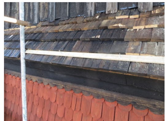
Ovan: Omläggning pågår på den nedtill avslutande delen av tornets övre parti.
