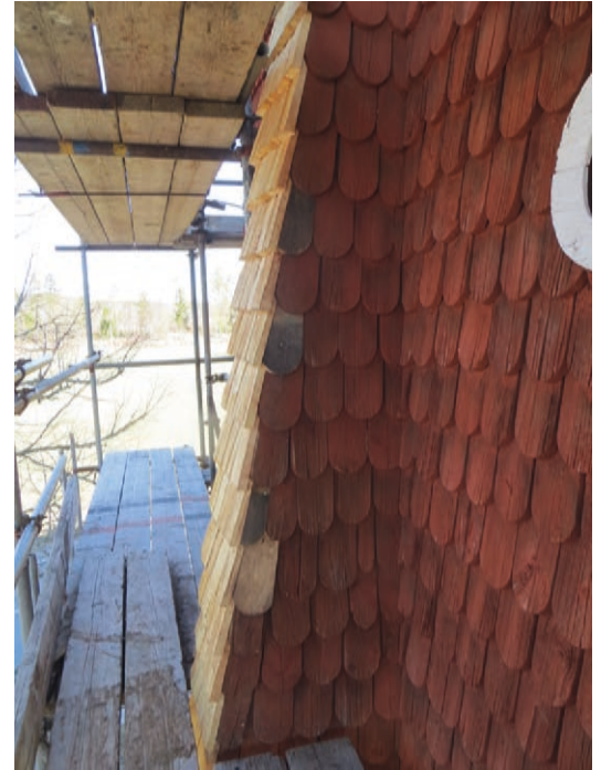
Ovan: Byte av spån på snedsträvan pågår. Till vänster: Det nedersta spånpartiet på tornet inför omläggningen. Här var rötskadorna mer begränsade. Nedan: Snedsträvan efter spånbyte, rödfärgning och rödtjärning.
