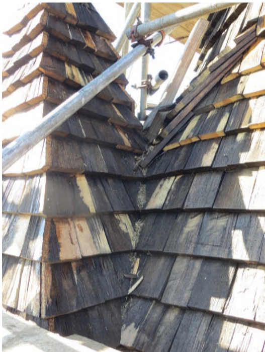
En turell efter omläggning där spånraderna ändrats så att de blev horisontella.
