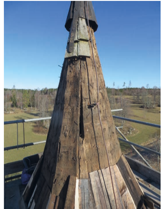
Spirans topp hade begränsade rötskador som här lagades i med likvärdigt virke.
