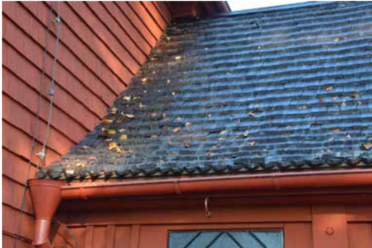
Branddetekteringskabeln på kyrkan var fri från stänk.
