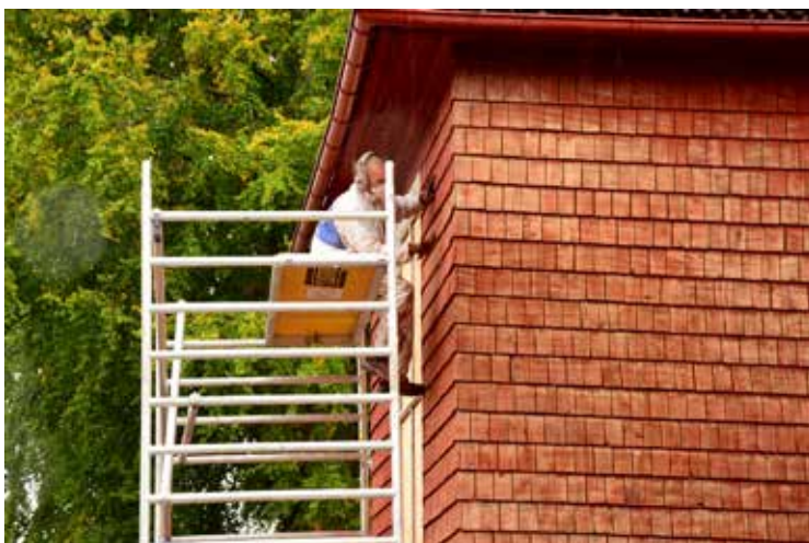
Strykning med rödfärg på den dessförinnan väl rengjorda fasaden.
