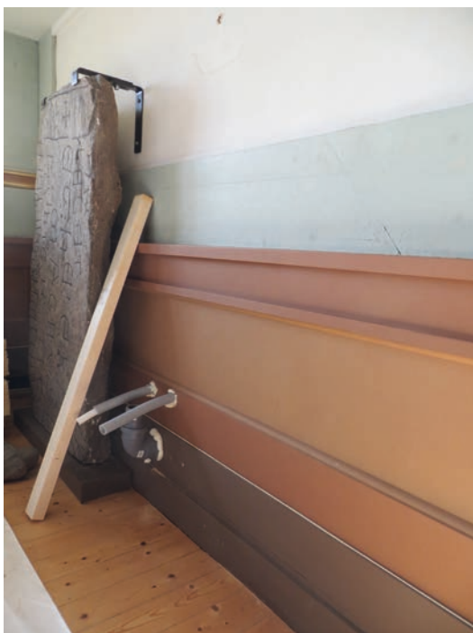
Ovan: Detalj av den panelförsedda väggen där pentryt senare byggdes. Panelen bakom de tillkommande köksskåpen behölls och skåpen anpassades efter panelen. Runstenen flyttades ut i vapenhuset. Till höger: Arbetet med pentryt under läktaren har påbörjats.
