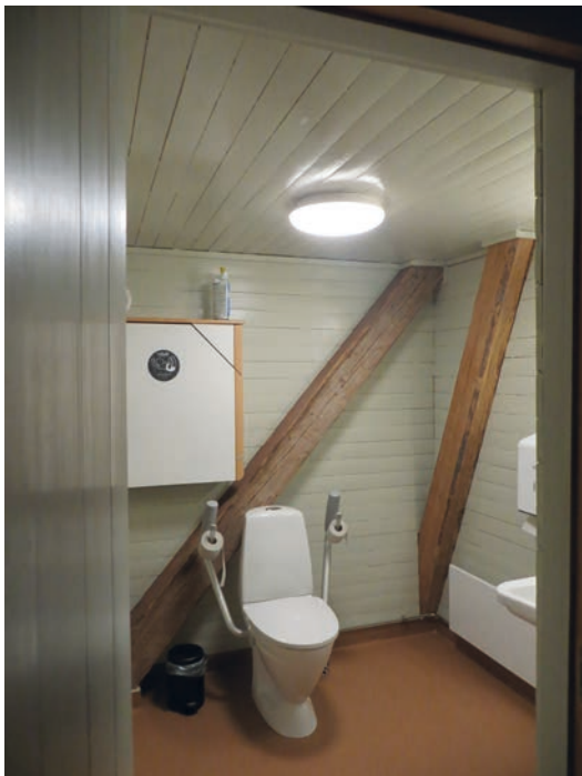
Ovan: Den färdiga toaletten med tornets konstruktion delvis synlig. Till höger: Den nya ventilen till toaletten inför målning.
