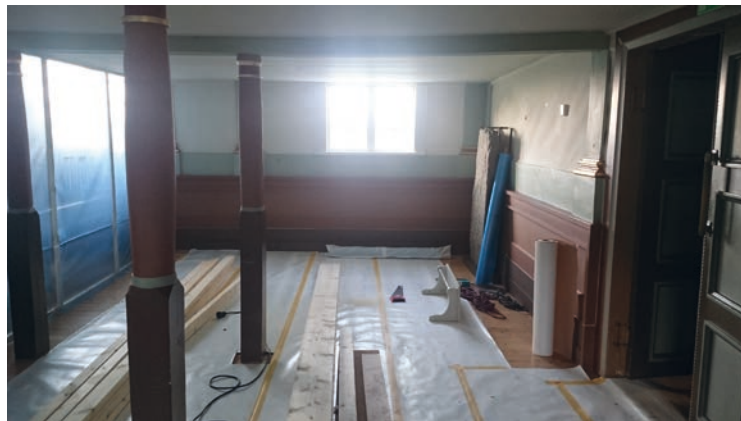
Ovan: Detalj av den panelförsedda väggen där pentryt senare byggdes. Panelen bakom de tillkommande köksskåpen behölls och skåpen anpassades efter panelen. Runstenen flyttades ut i vapenhuset. Till höger: Arbetet med pentryt under läktaren har påbörjats.
