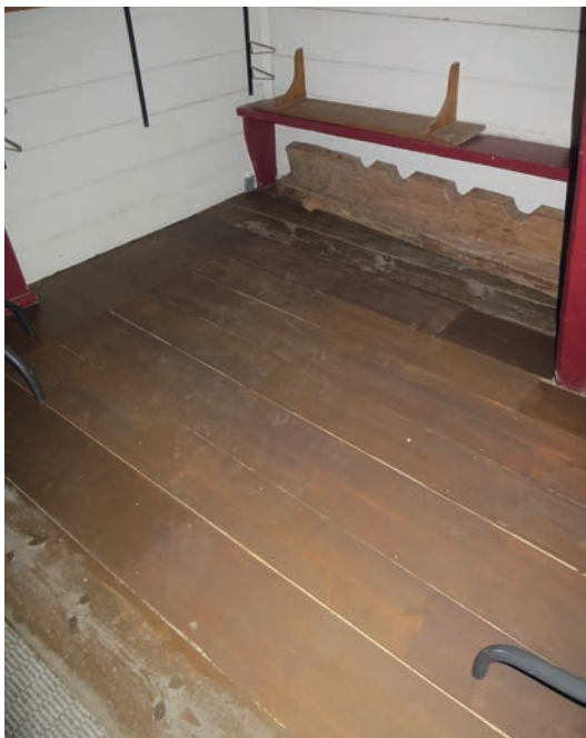
Ovan: Den slopade trappuppgången inför arbetena. Nedan: Golvet en trappa upp efter ilagningen av den borttagna trappan.
