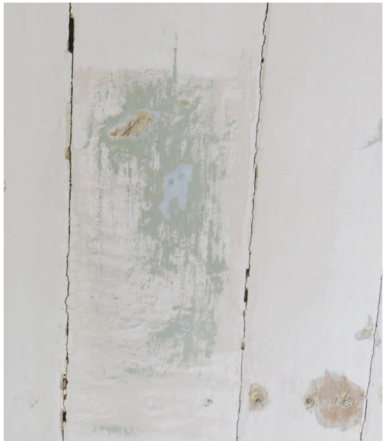
Skrapprov i korets tak som illustrerar den bedömda färgtrappan med kulörer i blått, grönt och vitt.
