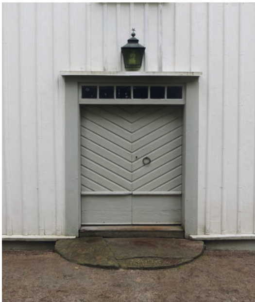
Kyrkans västentré med de nivåskillnader som fanns inför arbetena.
