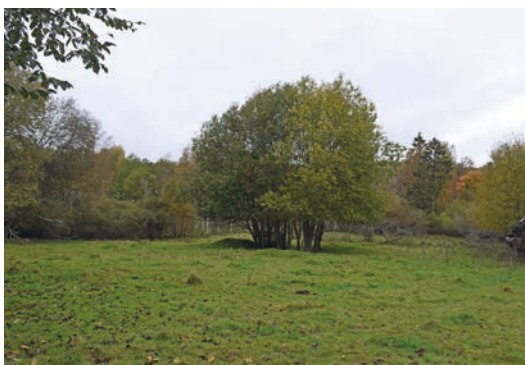
Figur 10. Område 2. Foto taget inne i betesmarken före schaktning, mot NV.
