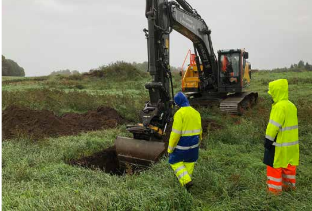
Figur 3. För att komma åt den övertäckta torvmarken vid Sandseryd 441 användes en grävmaskin som snabbt schaktade bort de ytliga lagren med matjord och sand. Foto: Leif Björkman, 2018-09-12.
