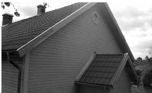
Nya stormplåtar och sattes på taket och på förstukvis- ten.
