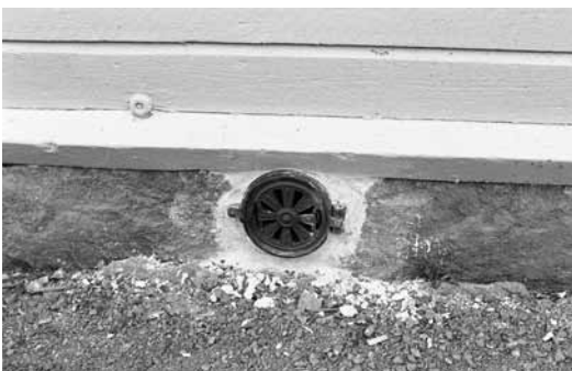
Fogarna var inte infärgade vid slutbesiktningen.
