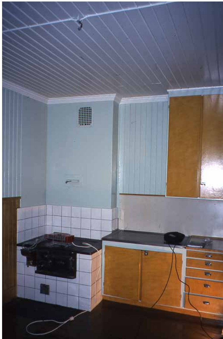
Köket i lägenheten efter avslutat arbete.
