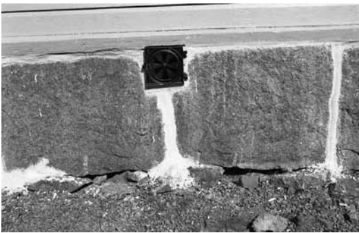
Fogarna var inte infärgade vid slutbesiktningen.
