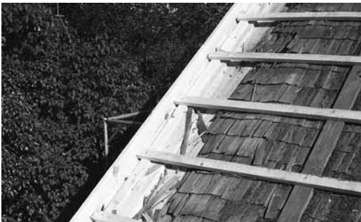
Det var enstaka skador i takbotten, här i takfallet över entrén.
