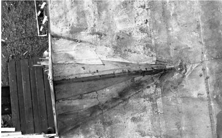
Förstukvistens tak, när cementpannorna är borttagna, fotograferat uppifrån.
