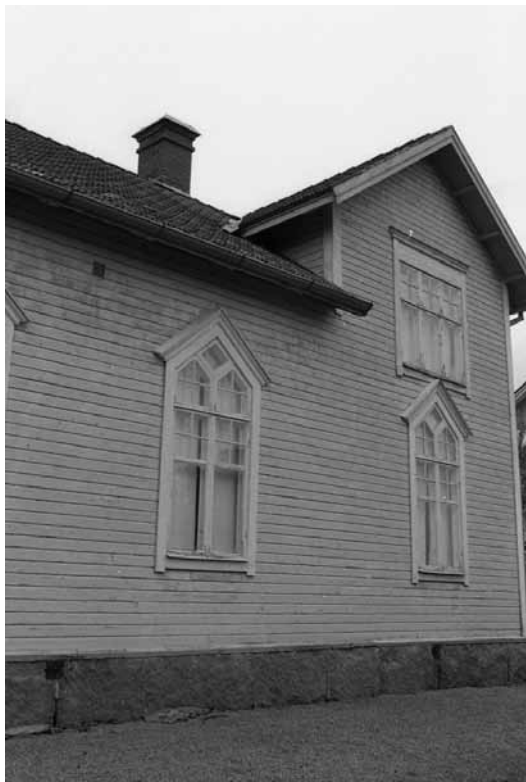
Byggnaden före åtgärderna.
