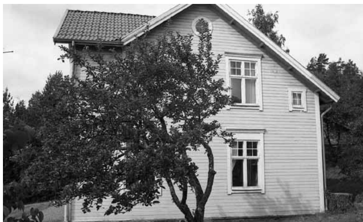
Byggnaden från öster, delar av vindskivan är bytt.
