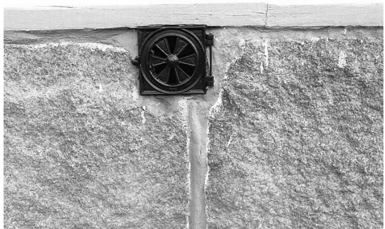
Garantiåtgärderna på fogarna åtgärdades i samband med arbeten 2001.
