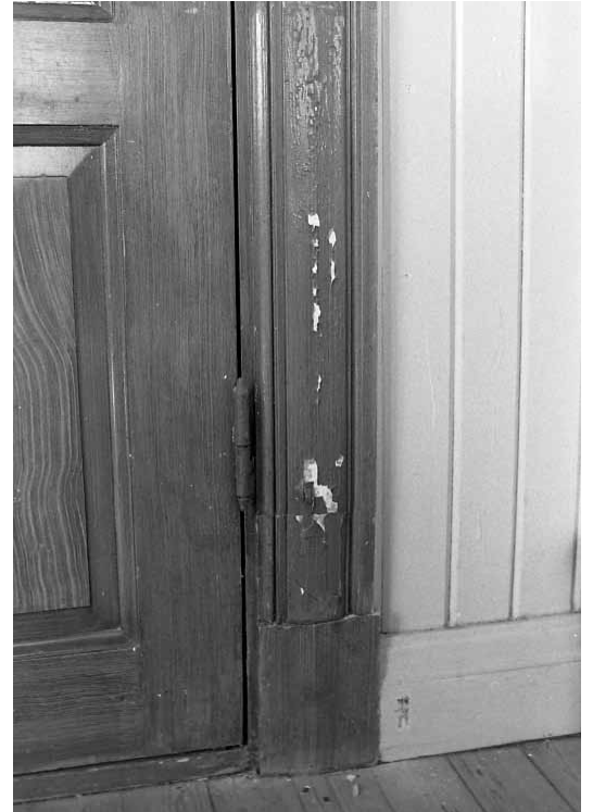
Målningen var flagad och krackelerad, detalj dörrpost i stora salen in mot köket. Till vänster salen innan åtgärd.
