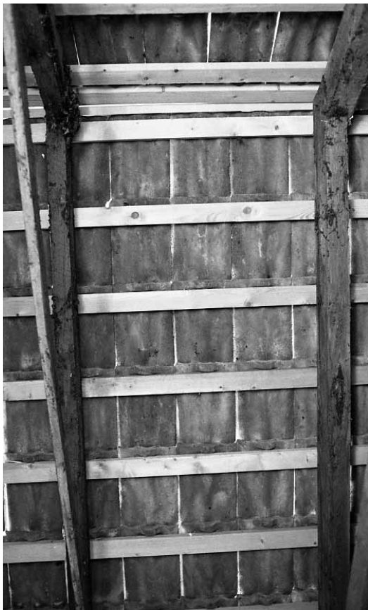
Uthusets tak ligger på öppen läkt. Bärläkten byttes genomgående.
