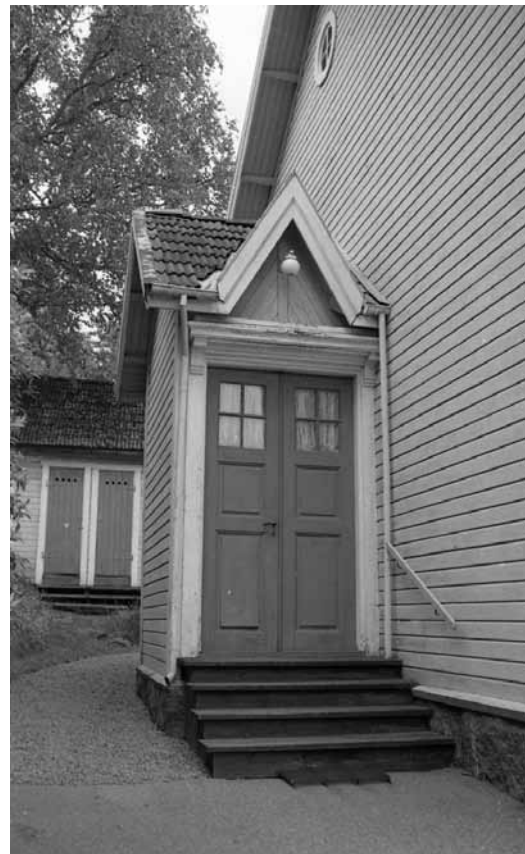
Byggnaden före åtgärderna.
