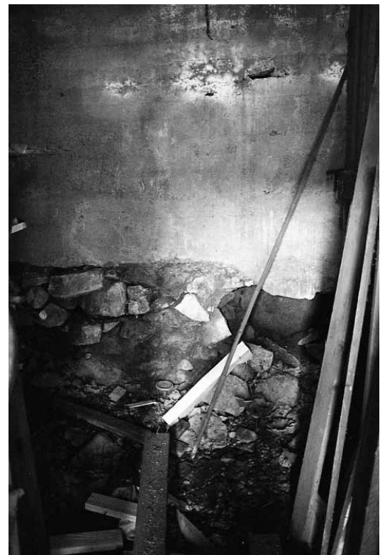
Nedan muren i uthuset före åtgärd. Till vänster översiktsbild före åtgärd.
