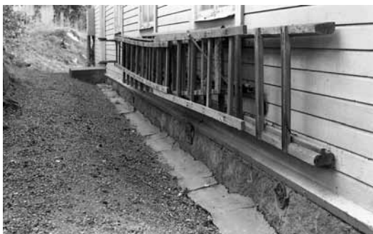
Baksidan före åtgärd.
