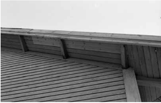
Ny bräda i takfoten samt lagning av vindskivan
