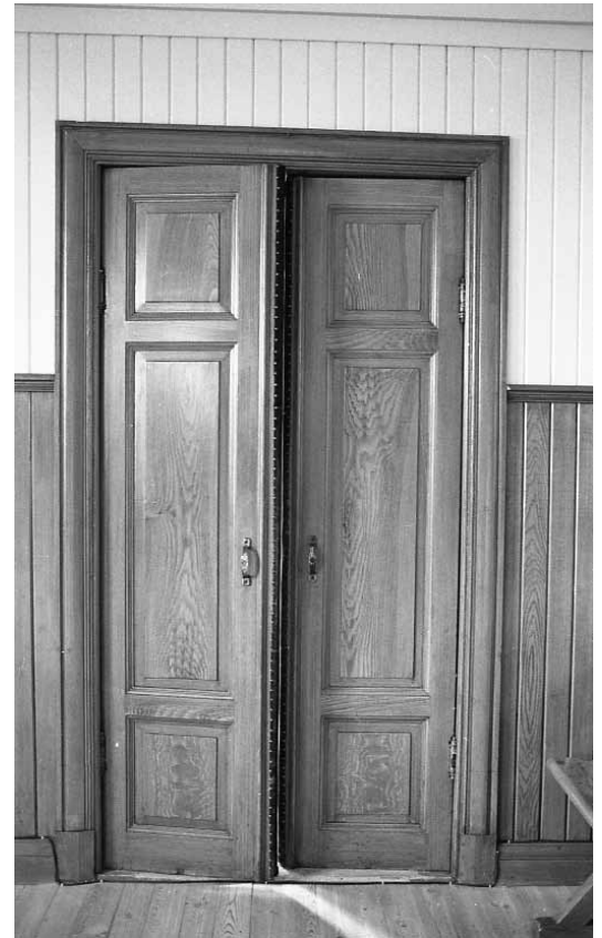
Entrédörrarna in till salen bättringsmålades.
