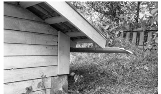
Uthuset efter åtgärd, ny bärläkt och hängränna monterad.
