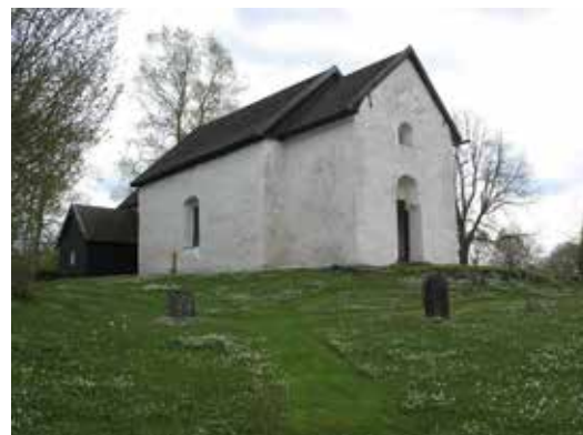
Norra och västra fasaden av kyrkan.
