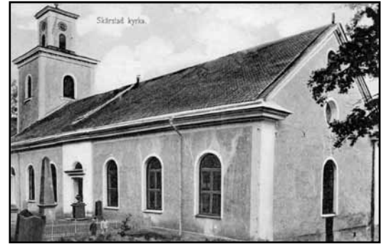
Detta fotografi från förra sekelskiftet visar att kyrkan då hade en spritputs avfärgad i mörkare ton. Detta framhävde på ett tydligare sätt arkitekturen.ATA.
