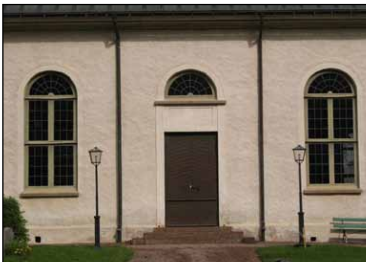
Mittport med karaktäristiskt överljus i form av en s.k. lunett. Fönsterbågarna med blyinfattat glas är från restaureringen 1932. Mittportens stomme är från byggnadstiden.
