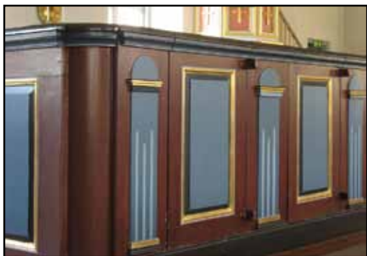
Sluten bänkinredning från byggnadstiden, modifierade 1932 och försedda med skarp ny färgsättning 1969.
