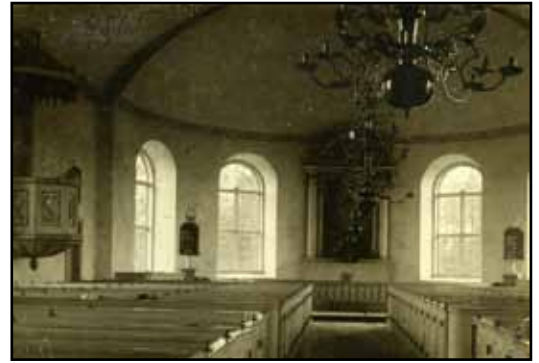
Interiörfotografi taget vid okänt tillfälle innan 1922 års omdaning då de mellersta fönstren igenmurades. Sedermera har takmålning och ny korinredning utförts. JLM.
