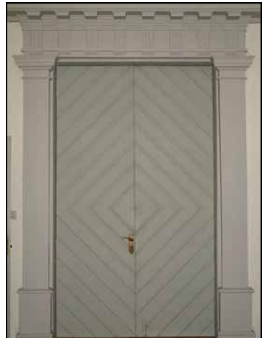
De ursprungliga entréportarna har påkostade nyklassicistiska omfattningar.
