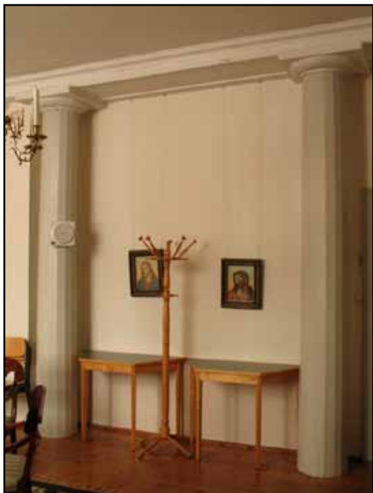
Läktarens doriska kolonner dolda inom läktarunderbyggnaderna.
