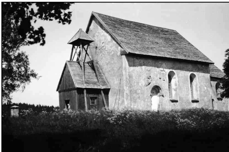
Fotografi av Sven Brandel från 1926 då kyrkan stod i princip öde. Klockstapeln var anbringad ovanpå vapenhuset sedan 1800-talet. ATA.
