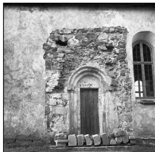
Fotografi av Erik Lundberg från 1937 som visar sydportalen innan baldakinens rekonstruktion. I murverket syns dess utsträckning och framför porten står de delar som hade återfunnits. ATA.
