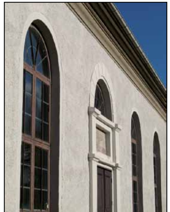
Sydfasad med mittport som understryker symmetrin. Fönsterbågarna är från byggnadstiden.
