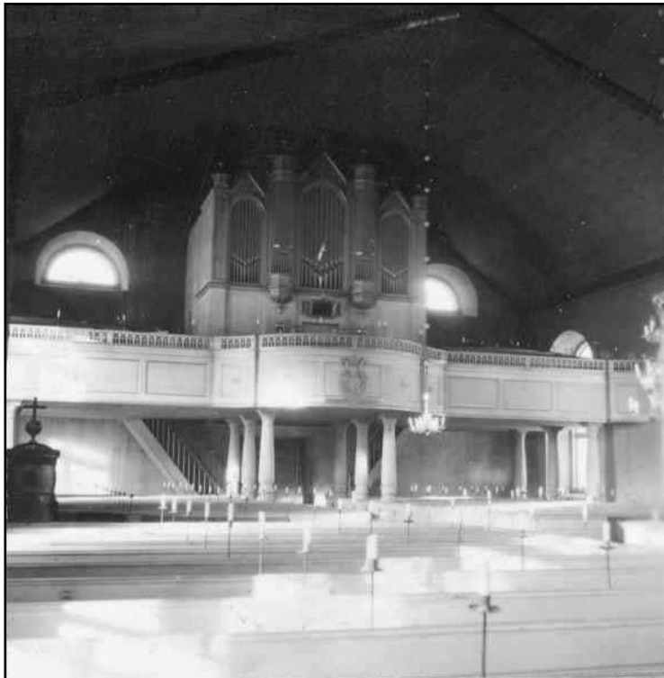
Äldre fotografi som visar interiören innan 1951 års restaurering då läktarunderbyggnad tillkom. ATA.
