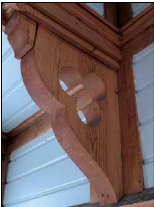
Även i den sedan länge igensatta lanterninen finns en hantverksmässig omsorg om detaljerna.
