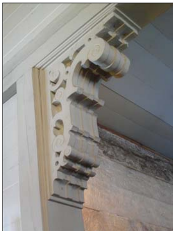
Konsol i öppning mellan kor och långhus, troligen från 1895 års restaurering.
