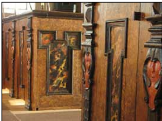
Sluten bänkinredning med ursprungliga dörrar, gavlar och skärmar i renässans. Framtagen bemålning med bl.a. fläckmarmorering som imiterar sköldpadd.
