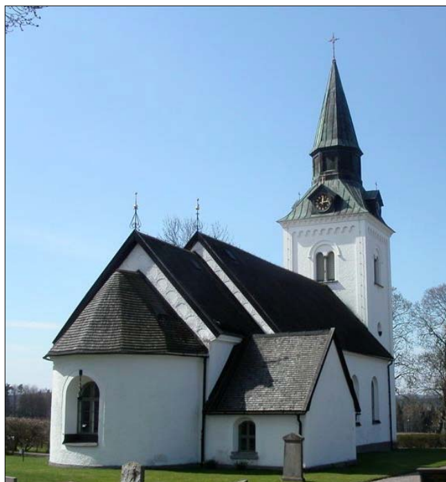
Koret och norra långsidan med sakristian från 1300-talet. Tornet har en tydlig prägel av sent 1800-tal med intresse för historiserande detaljer.
