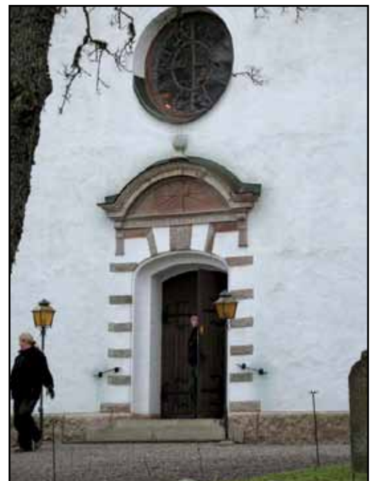
Kalkstensornamenten kring västupporten är det enda som idag är synligt av tornets fasaddekor från 1902.
