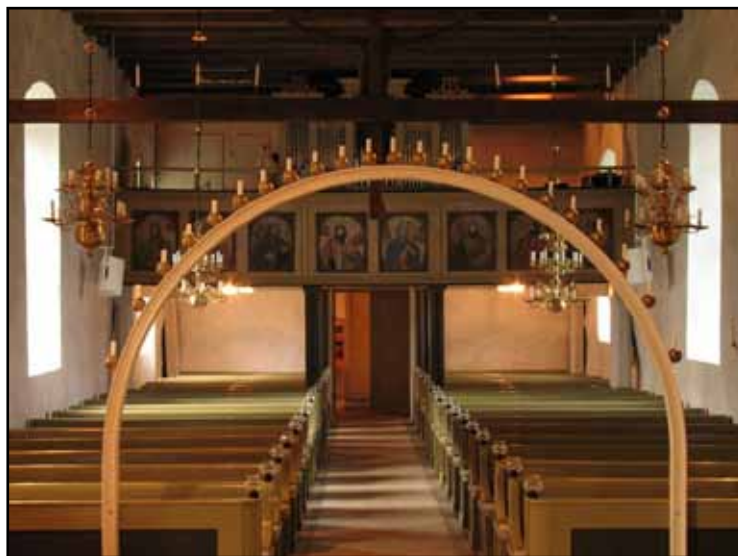
Den öppna romanska takstolen är interiörens främsta karaktärsdrag.
