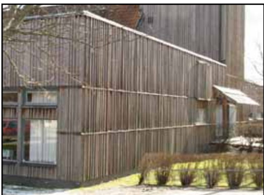
Fasadbeklädnaden av tryckimpregnerad furu består av lockbräder med olika bredd och kraftiga läkt, vilket skapar en viss rytm.
