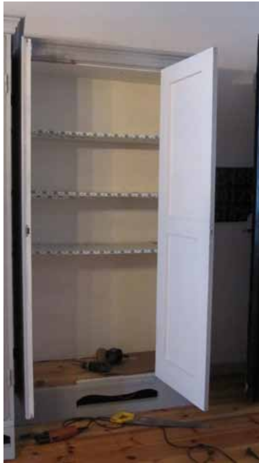
Högra skåpet före åtgärd. Här kompletteras antalet hyllor.
