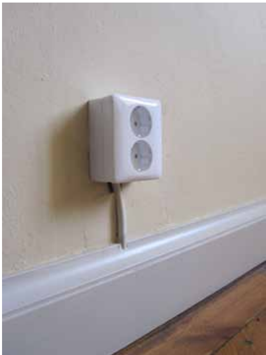
Ny golvlist med utrymme för kabeldragning enligt arkitektens ritningar.
