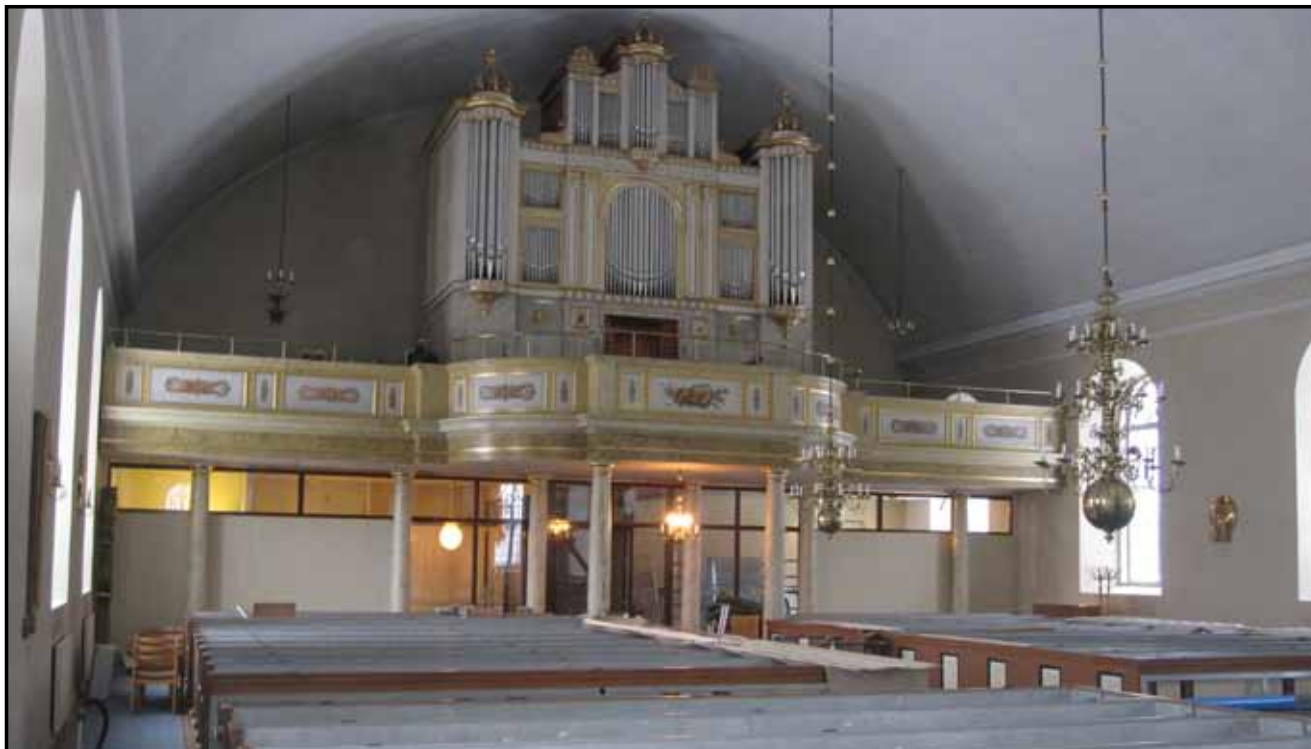
Den nya läktarunderbyggnaden vid slutbesiktningen.
