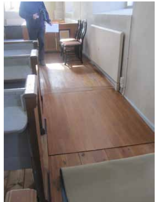
Den nyuppförda rampen till koret.
