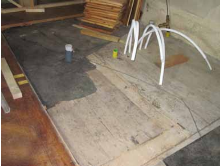
Delar av det ursprungliga brädgolvet blottades vid ombyggnaden. Det består av breda såpskurade brädor.
