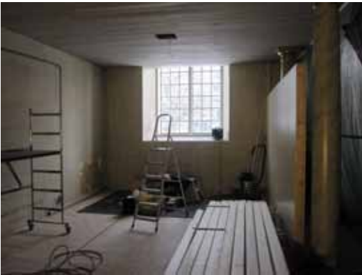
Läktarunderbyggnaden under uppförandet. Fönstret i fonden har återupptagits.
