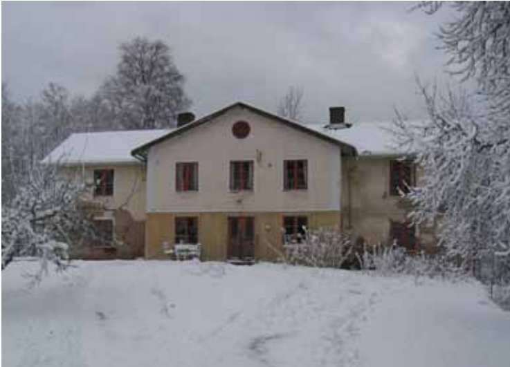
Manbyggnaden på gården Fråstorp 1:7 före fasadarbetena, vid besiktning 2005. Foto: Britt-Marie Börjesgård.
