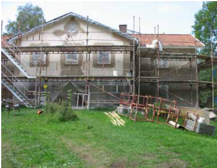
I huvudfasaden kunde ett större parti av den äldre putsen bevaras.
