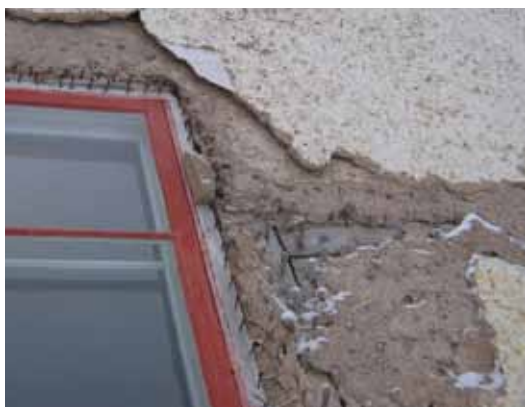
Spår av en trolig äldre fönsteröppning i bottenvåningen.
