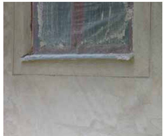
De slätputsade fönsteromfattningarna avgränsades med en ristning i putsytan.
