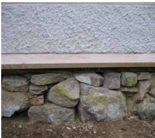
Putsfasaden avslutades nedåt med en ny fotbräda i trä.
