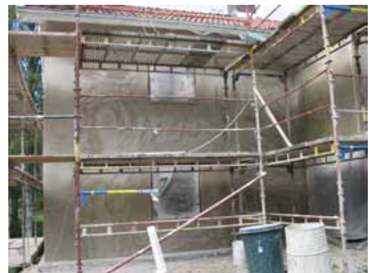
Fasaden efter att utstockningen slagits på.
