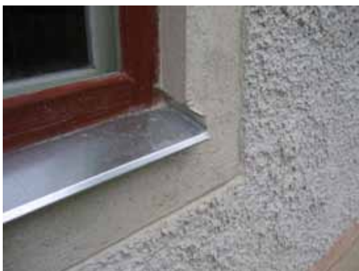
Samtliga fönsterbleck ersattes med nya i galvad plåt. De utfördes med de äldre som förlaga med undantag av en sentida sk puts kant vid gavlarna.
