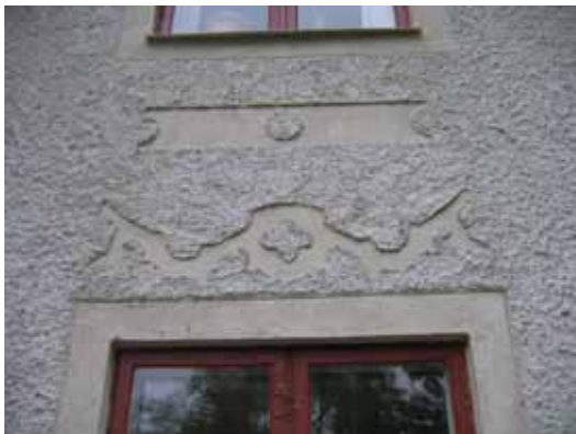
Fasaddekoren rekonstruerades med hjälp av träschabloner i den nya ytputsen.
