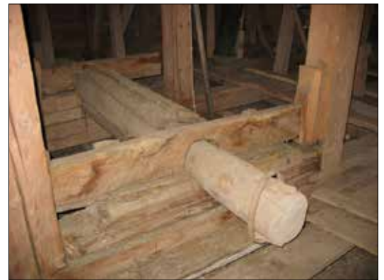
Till ovanligheterna hör att tornens uppfodringsverk finns kvar på ursprunglig plats. Detta användes när kyrkan byggdes för att hissa upp balkar, stenmaterial och tyngre föremål såsom kyrkklockorna.
