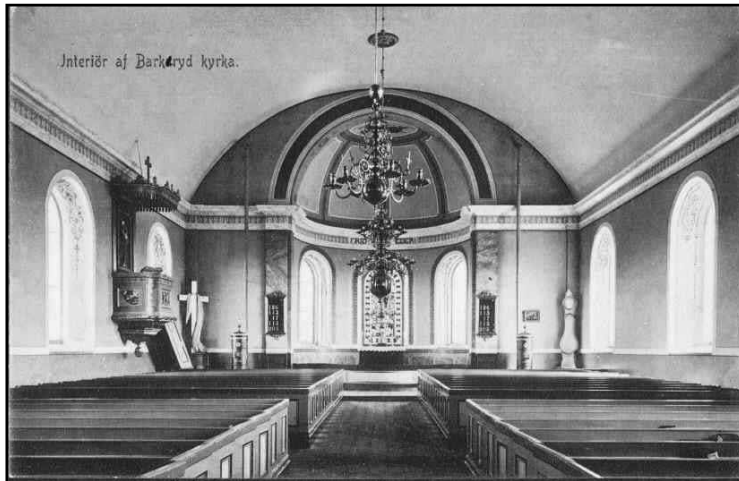
Interiör efter 1907 med kraftigt kulört färgsättning och dekormålerier. Marmoreringar och dekor på taklist, triumfbåge och absidbröstning är ännu kvar. Observera de båda järnkaminerna i koret. ATA.
