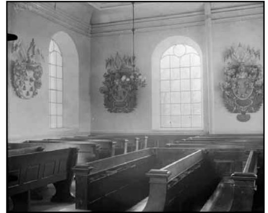
Fotografi taget av Oscar Svensson 1926 som visar södra korsarmen med öppen bänkinredning i mahognyimitation och gjutjärnsfönster från 1909. ATA.
