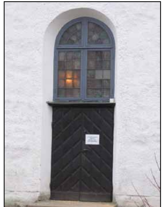
Dörrblad och antikglasfönster från 1935.
