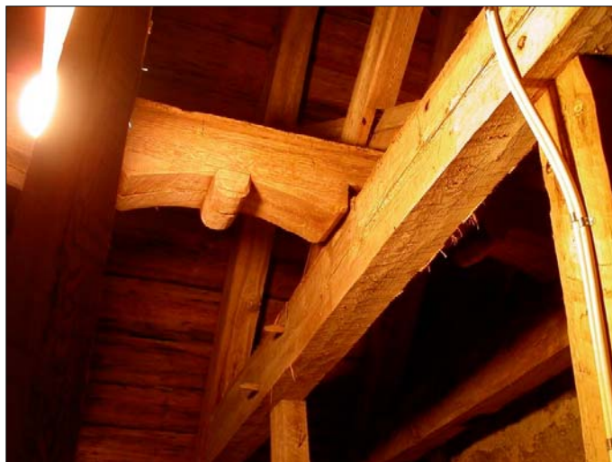
Del av snidad längsgående bjälke i takstolen med snidade detaljer. Troligen från medeltid.
