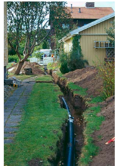
Figur 2. Ett av schakten för fjärrvärme i bostadsområdet Vättersnäs.
