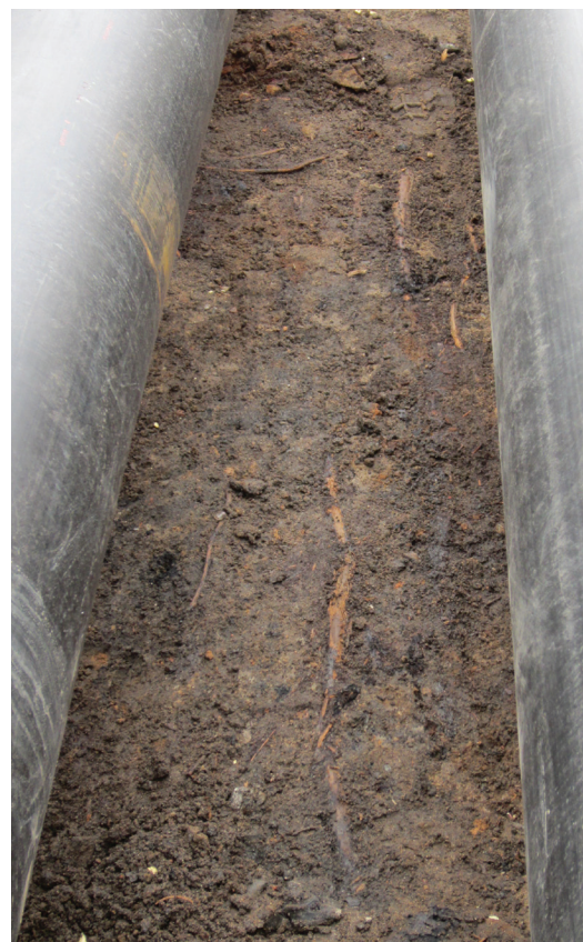
FIGUR 5. Botten av schaktet med risbäddslagret. De båda rören flankerar lagret. Risbädden ligger i nord-sydlig riktning.
