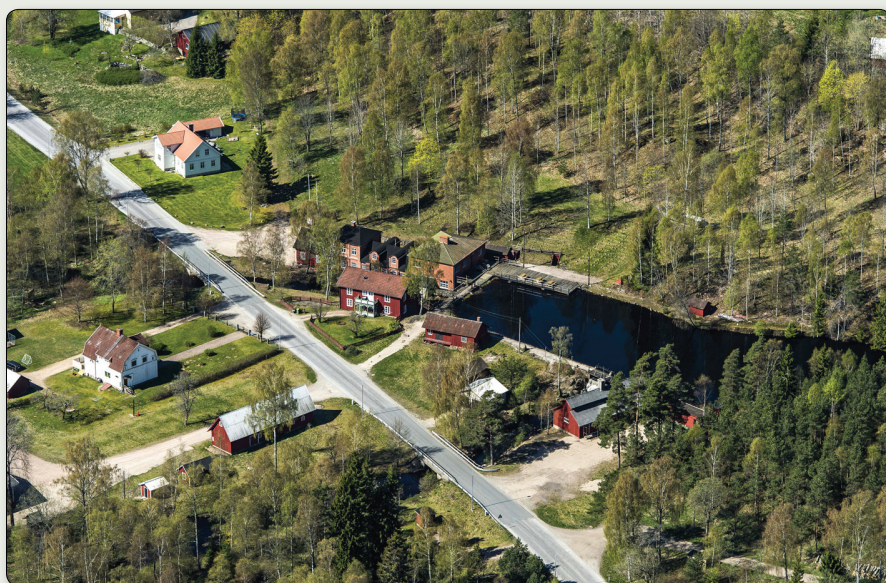
Industrimiljön Hylténs Metallvarufabrik vid Gåröström i Gnosjö. Foto Leif Gustavsson/L.G.foto
