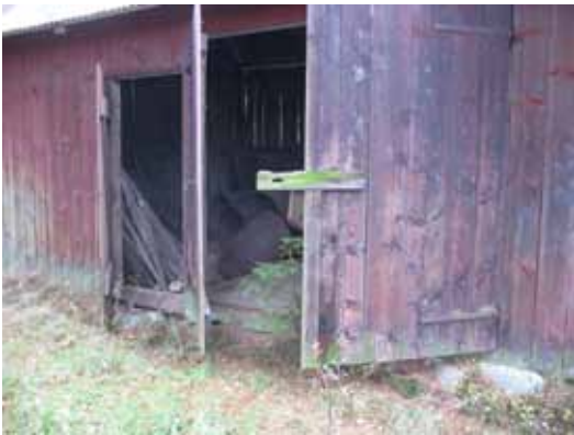
Denna ängslada i Ås socken, Gislaveds kommun, har för ovanlighetens skull en mindre sidodörr och brädgolv i genomkörningen. Kanske är det frågan om en kombination med ett så kallat sommarfåhus.
