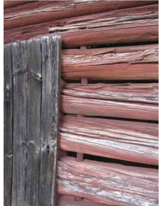
Det glesta timret hålls samman av dymlingar på sedvanligt sätt. På grund av den glesta timringen är dymlingarna mer synliga jämfört med tät timring.
