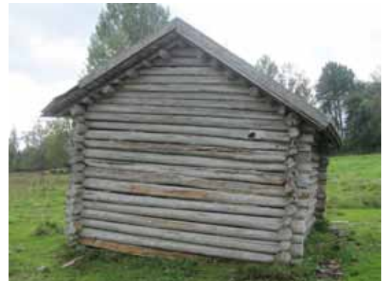
Många timrade ängslador har en takkonstruktion med så kallade mångåsar, d.v.s. tätt med längsgående åsar från gavel till gavel. Detta kan ses som ett tecken på att de var försedda med halmtak från början. Ängslada i Fågelhults by, Kråkshults socken, Eksjö kommun.
