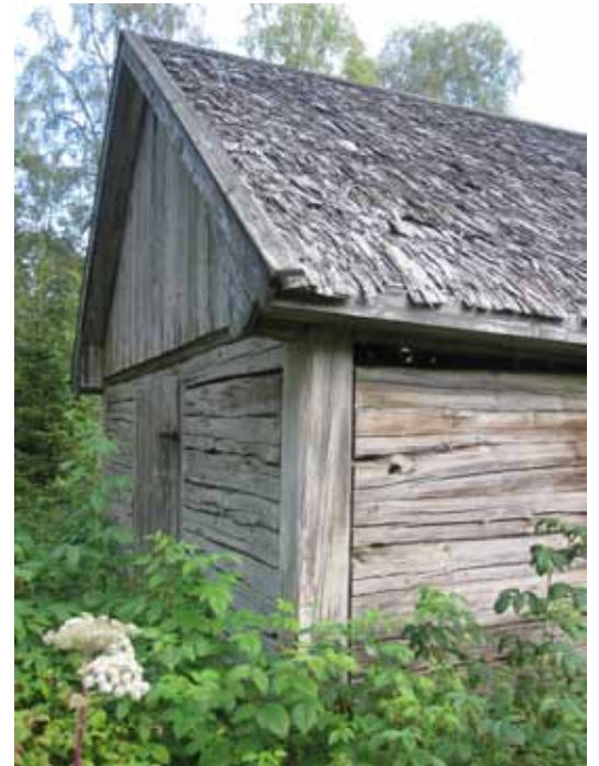
Ängsladan i Packebo (Malmbäcks socken, Nässjö kommun) är en av ytterst få med sticktak. Däremot är det vanligt att gamla sticktak ligger kvar under sentida plåttak.
