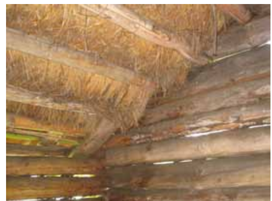
Ofta finns äldre sticktak bevarade under sentida plåttak, men i undantagsfall finns halmtak bevarade under nyare tak. Detta ger goda möjligheter till byggnadsarkeologiska undersökningar.
