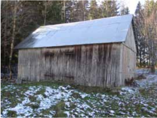
Ovan: Ängslada med protar på mitten av båda långsidorna (Korpebo, Malmbäcks socken, Nässjö kommun).
