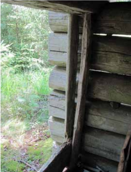
Denna ängslada i byn Näs (Ingatorps socken, Eksjö kommun) har en stängningsanordning med parställda följare på vardera sidan om öppningen. Brädor lades mellan följarna för att stänga ladan.
