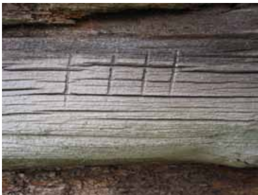
Många ängslador har flyttats och är därför försedda med markeringar som använts i samband med demontering och återuppbyggnad. Om en lada skulle flyttas en kortare sträcka kunde man troligen rulla byggnaden på stockar utan att demontera den.
