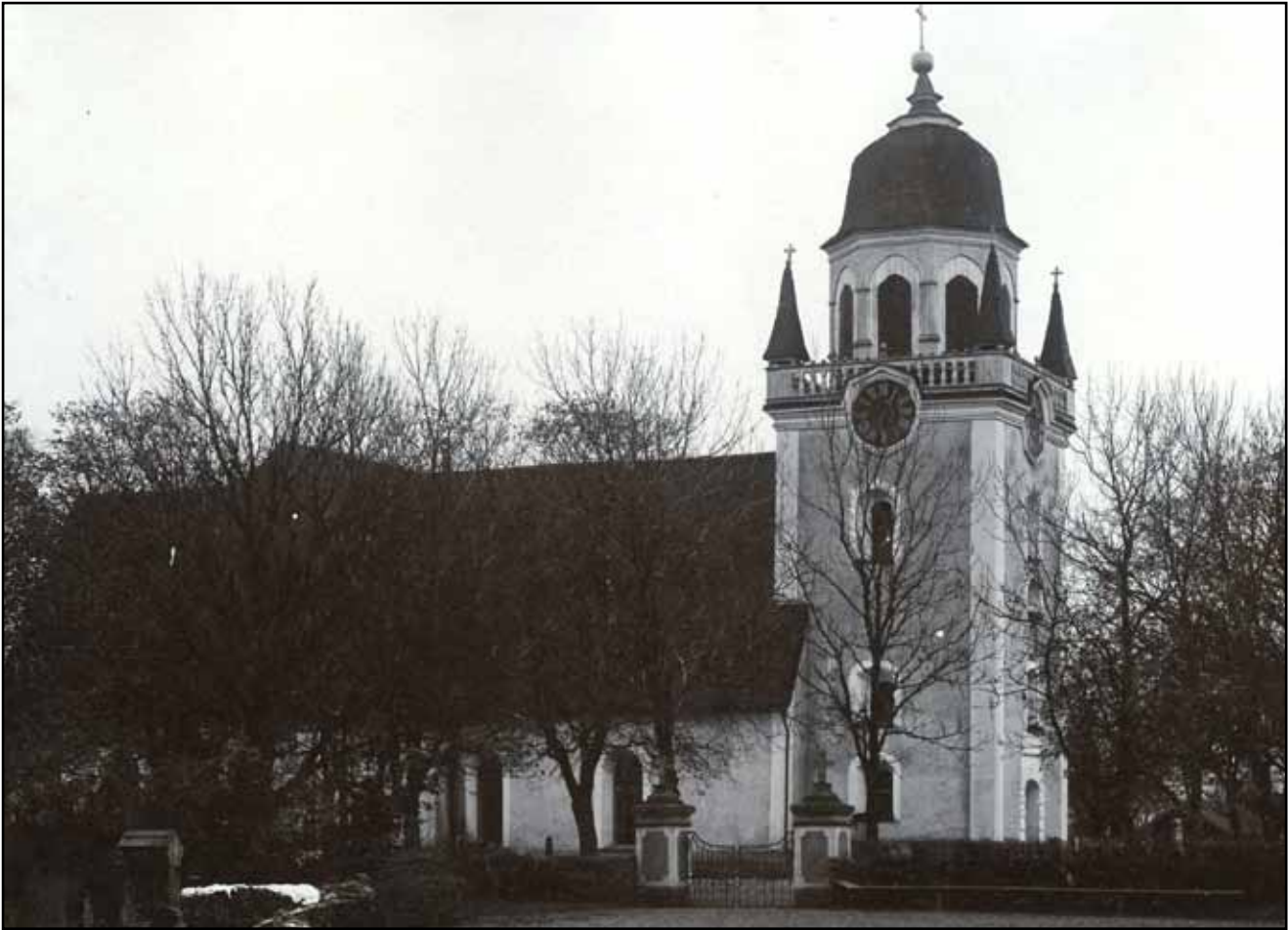
Ett av de äldsta kända fotografierna av Säby kyrka är taget 1895 och visar henne i den skepnad hon fick efter 1887 års stora restaurering: kulört spritputs och slätputsade, vita hörnomfattningar. Tornlanterninens bemålning i grått med marmoreringar på pilastrar, bågar och balustrad är klart skönjbar. JLM.
