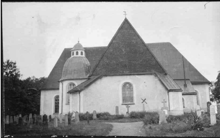
Säby kyrka fotograferad från öster 1911 av ingenjör Algot Friberg. Notera spritputsens och de stora gjutjärnsfönstren i kor och gravkor, vilka sedermera avlägsnades vid kommande restaureringar. ATA.
