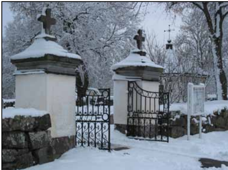
Västra grindstolparna efter ny avfärgning.
