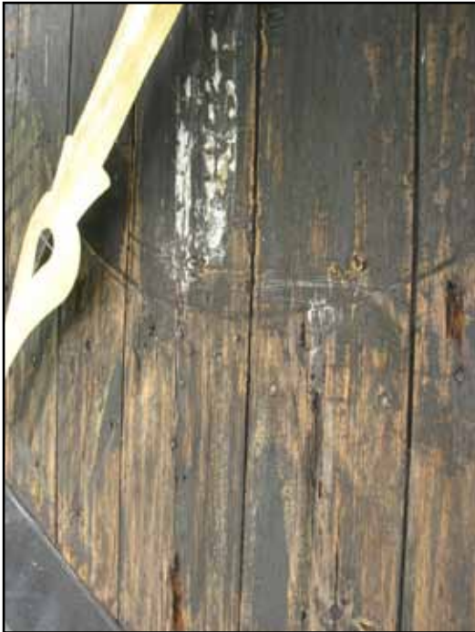
Skador på den västra urtavlan, tidigare lagade med plastic padding. Notera att nuvarande plåtsiffror är demonterade och att det syns tydliga spår av att originalsiffrorna var målade direkt på träet.
