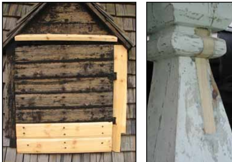
Till vänster: Lanterninhuvens lucka åt öster har kompletterats med ny dropp-list, foderbräda och två panelbrädor är utbytta, allt är fäst med smidd spik. Till höger: Illusning på en av balusterdockorna åt norr.
