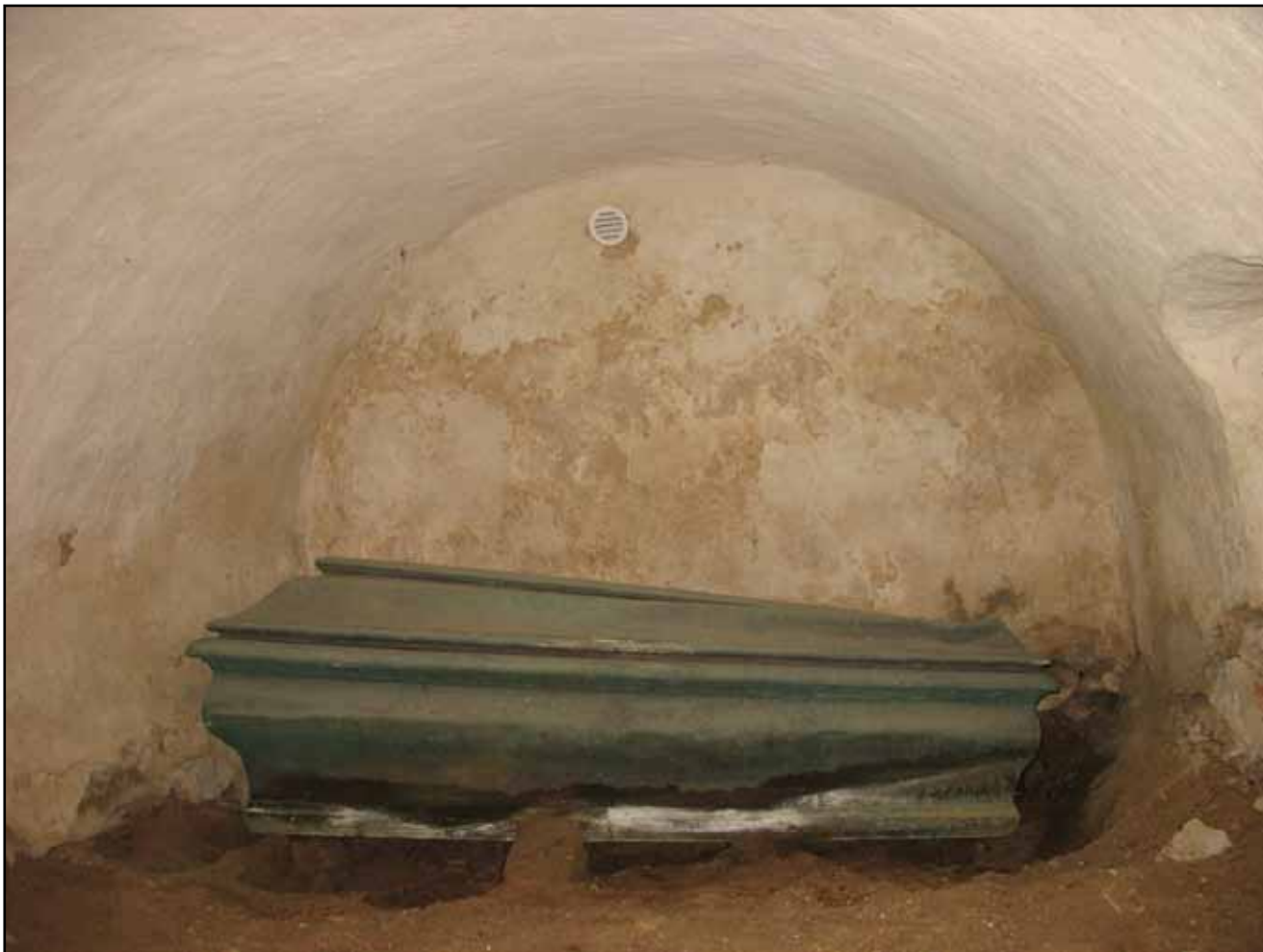
Hägerflychtska graven efter avslutade arbeten. Utblås monterat i gavel med inmalat don. Kistans botten framrensad. Notera tegelmurarna som burit de nu förmultnade träkistorna. Kistan är endast avborstad.
