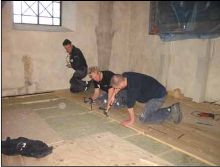
Magnus Svenäng, Ola Jönsson och Lukas Johansson lägger nya golvbräder ovanpå det isolerade bjälklaget.
