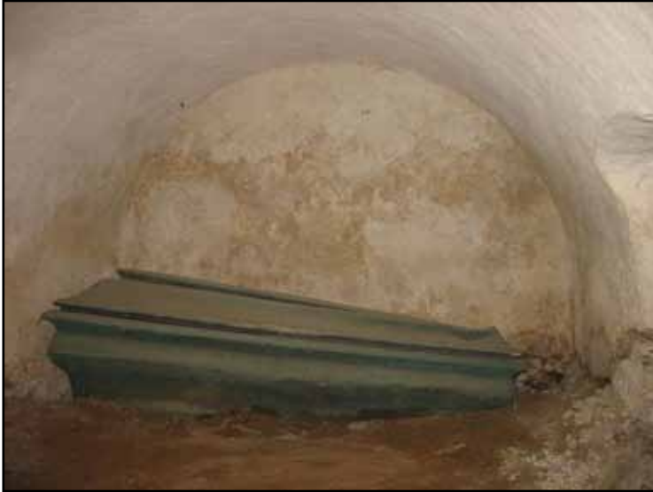
Hägerflychtska graven med kopparkistan före arbetena.
