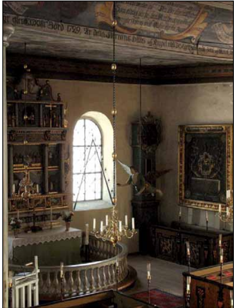
Koret och golvet före upptagning av sistnämnda. Furugolv från 1970-talet med skurgolvsimiterande oljning. Rockwollisolerad lucka för trappan ned till Hägerflychtska graven.
