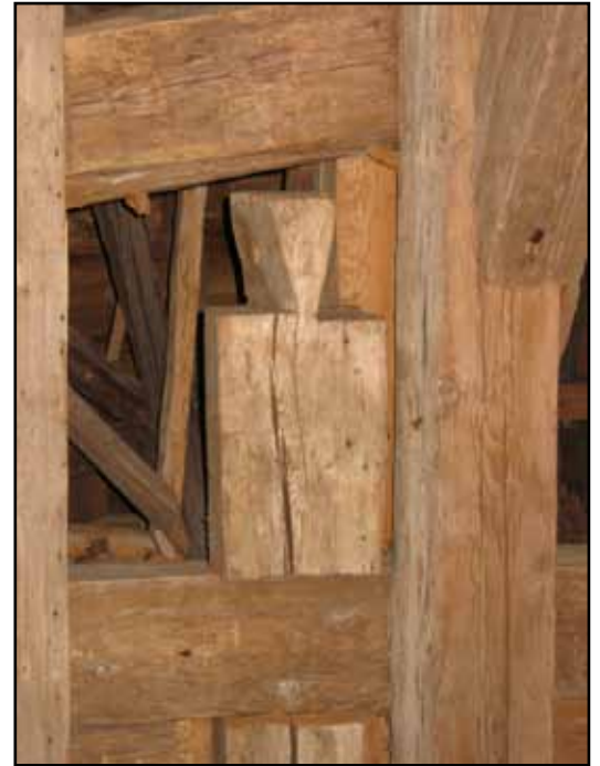
Återanvänd furubjälke med laxad knut.
