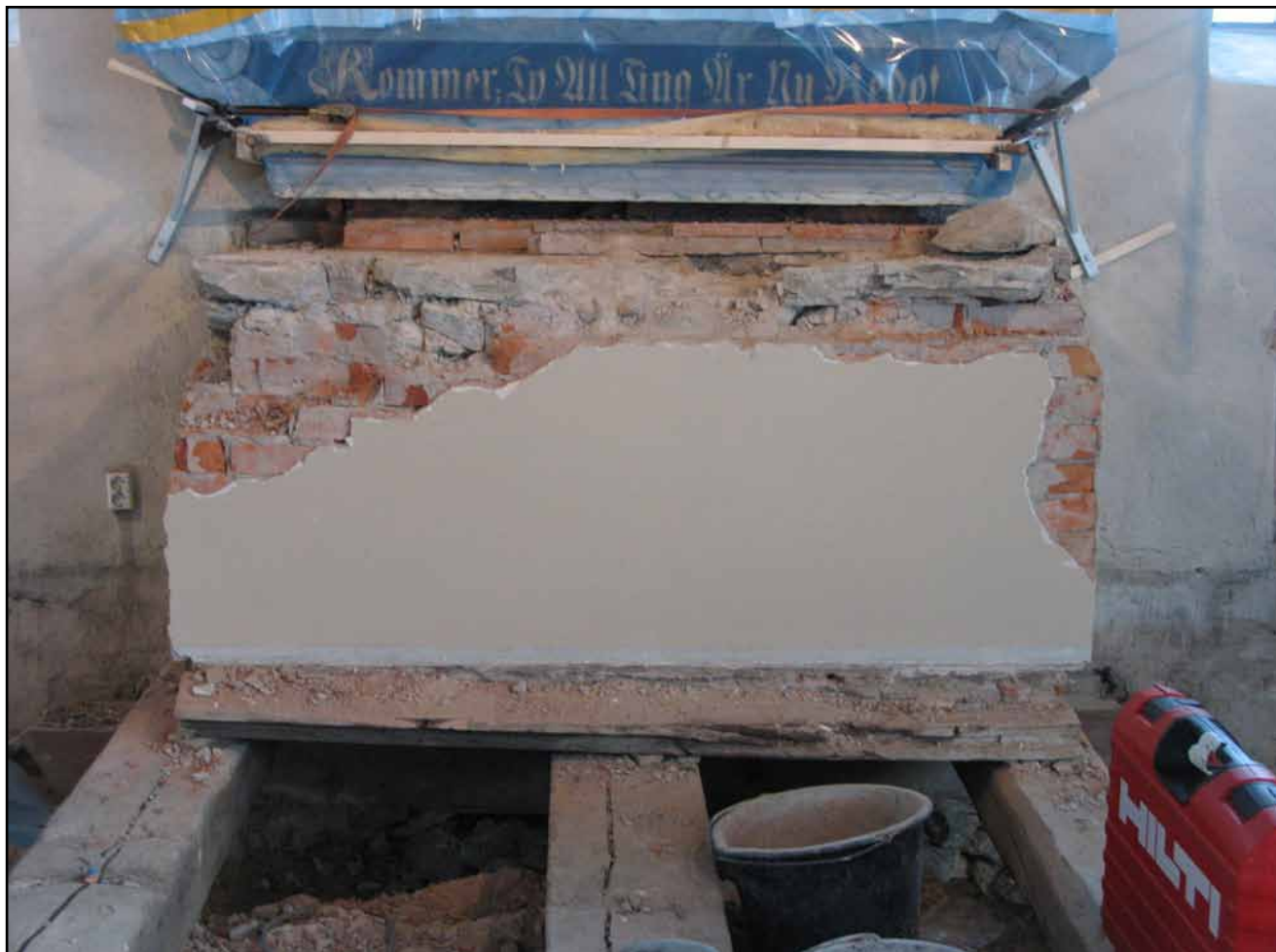
Altaret från 1694 före demontering. Det är massivt, murat av fältsten och sandsten, på ovasidan med tuktade sandstenschällar som bär spår av kalkfärg. Altaret förhöjdes och påmurades 1953 åt väster med tegel som har en cementhaltig slätputs med tät grå färg. Altaret är uppmurat på tre återanvända bjälkar från den medeltida timmerkyrkan samt två stavkyrkokopplankor.
