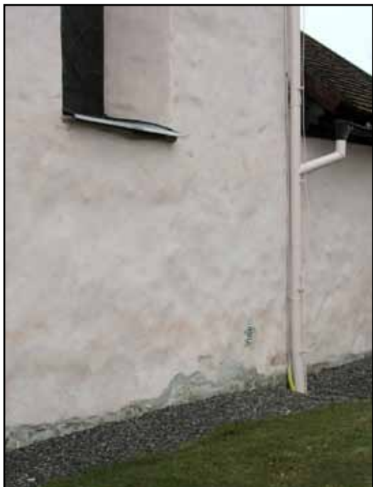
Genomföring av kormuren för utblås från avfuktningssystemet. Putslagning och inmålningsarbetet ännu inte utförd.
