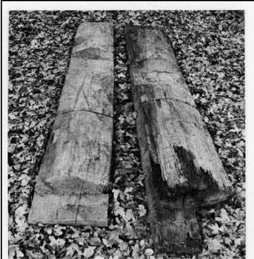
Fig 77 a–b. Stavkyrkoplankor av ek, påträffade vid restaurering av Aringsås (Alvesta) kyrka 1928 som golvbräder. Foto Mikael Ullén 1981.
