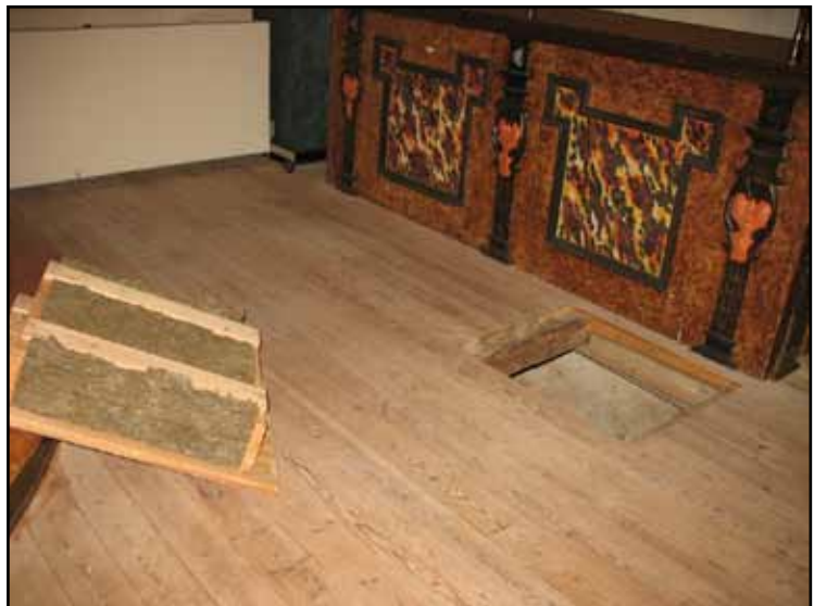
Koret och golvet före upptagning av sistnämnda. Furugolv från 1970-talet med skurgolvsimiterande oljning. Rockwollisolerad lucka för trappan ned till Hägerflychtska graven.
