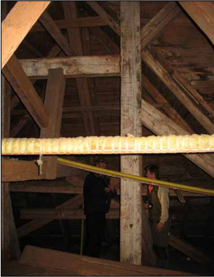
Återanvänd furubjälke med laxad knut.
