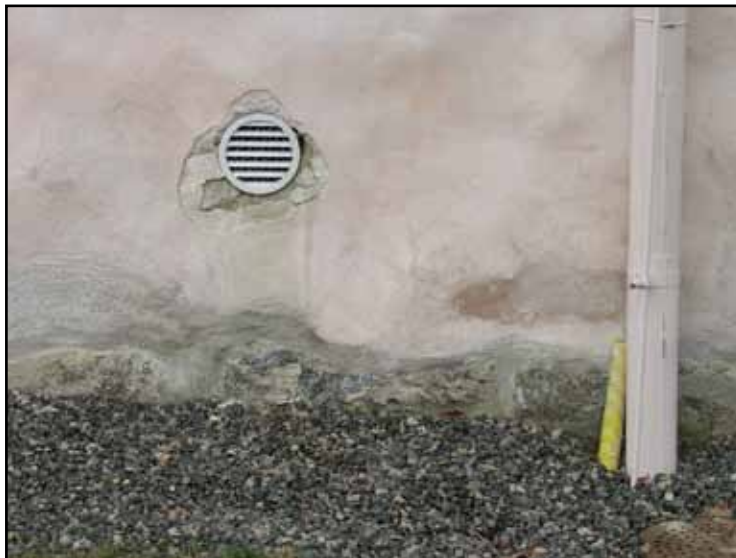
Genomföring av kormuren för utblås från avfuktningssystemet. Putslagning och inmålningsarbetet ännu inte utförd.
