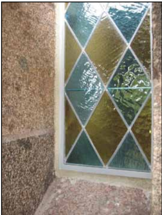
Ett av tornfönstren efter restaurering, monterade i ny stålarm.
