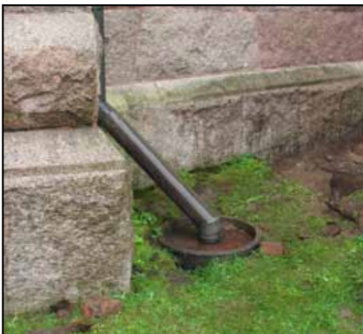
Detaljer av kyrkans fasader. Ovan till vänster, parti av södra långsidan. Ovan till höger, södra korsarmens entré. Till vänster, befintlig stuprörsanslutning till dagvattenledning. Nedan till vänster, en av tornets kopparplåtsklädda utkastare med dekorativa fåglar. Nedan exempel på olika fogar, rundfogen är den ursprungliga.
