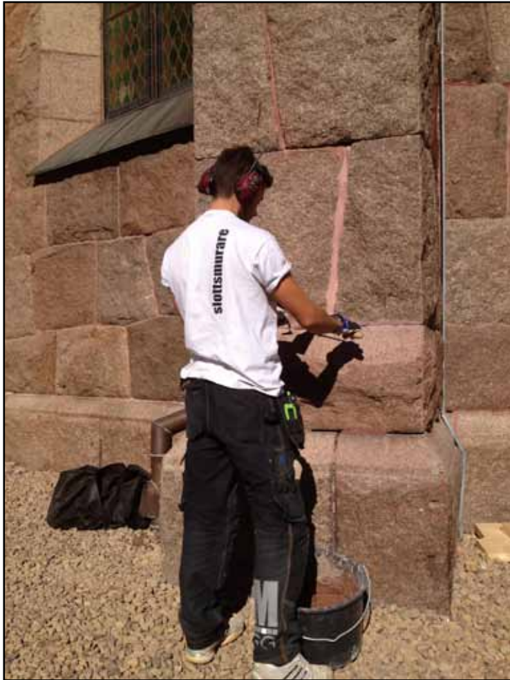
Omfogning av avtäckning och framsida på korets syd-östra strävpelare, under arbete och efter.
