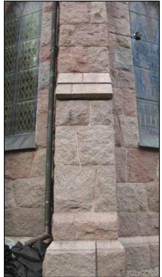
Omfogning av avtäckning och framsida på korets syd-östra strävpelare, under arbete och efter.
