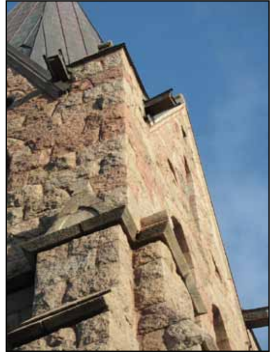
Tornet har åtta stycken utkastare. Dessa mynnar ovanför de dekorativa krönen på strävpelarna, vilka visade sig vara i mycket dålig skick.
