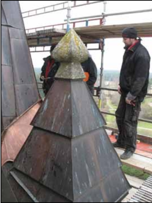
Vid hörnfialerna/turellerna gjordes nya ståldrännor för att leda över vattnet till de utkastare som försetts med stuprörsanslutning.
