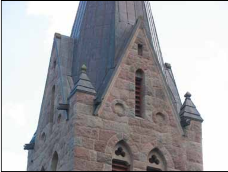
Tornet har åtta stycken utkastare. Dessa mynnar ovanför de dekorativa krönen på strävpelarna, vilka visade sig vara i mycket dålig skick.
