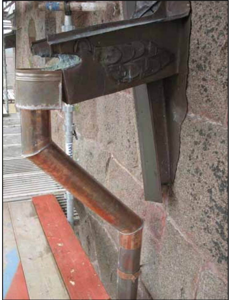
Nytt stuprör och vattkupa i koppar, anslutet till en av utkastarna.
