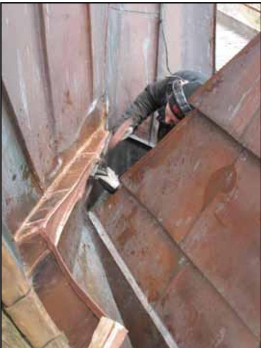
Arbete på en av de nya ståldrännorna.
