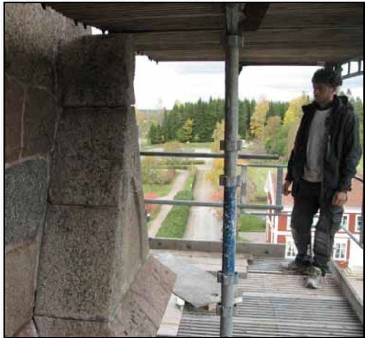
Strävpelarnas krön hade överlag mycket dåligt fäste mot muren. Pierre Nilsson, RM-Bygg visar på hur stora delar av bruket var urlakat eller bortspolat, sannolikt en av de stora källorna till vatteninträngning i tornets murverk.
