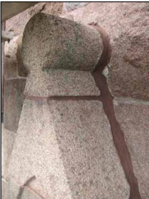
Stora mängder bruk gick åt för att bygga upp en ny fog mellan krön och mur, i praktiken rörde det sig närmast om en ommurning.
