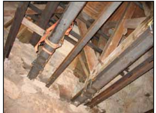
Det nya stålbjälklaget före inläggning av golv.
