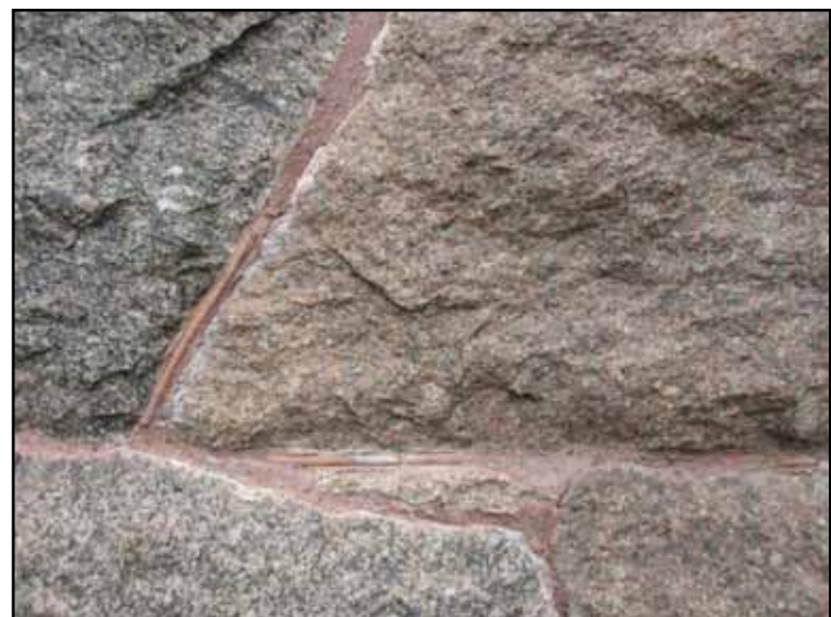
Detaljer av kyrkans fasader. Ovan till vänster, parti av södra långsidan. Ovan till höger, södra korsarmens entré. Till vänster, befintlig stuprörsanslutning till dagvattenledning. Nedan till vänster, en av tornets kopparplåtsklädda utkastare med dekorativa fåglar. Nedan exempel på olika fogar, rundfogen är den ursprungliga.
