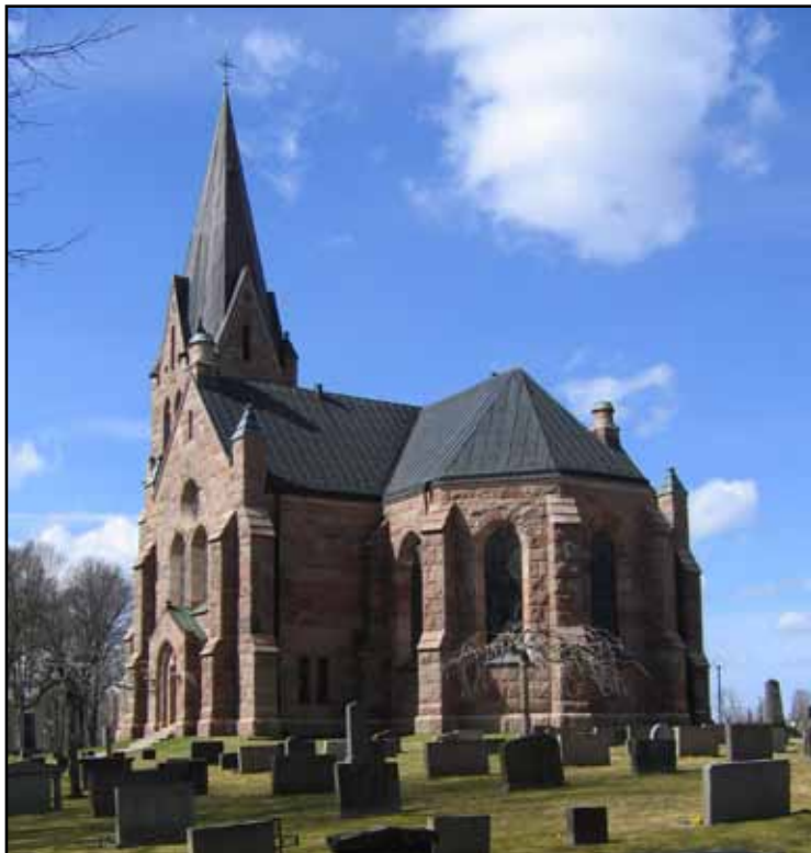
Tornet har åtta stycken utkastare. Dessa mynnar ovanför de dekorativa krönen på strävpelarna, vilka visade sig vara i mycket dålig skick.
