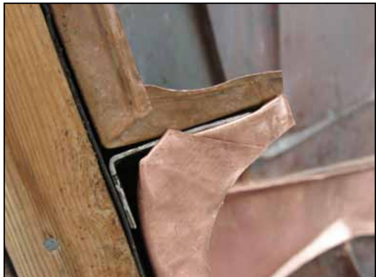
Stomme av vinkeljärn i ny ståldränna.
