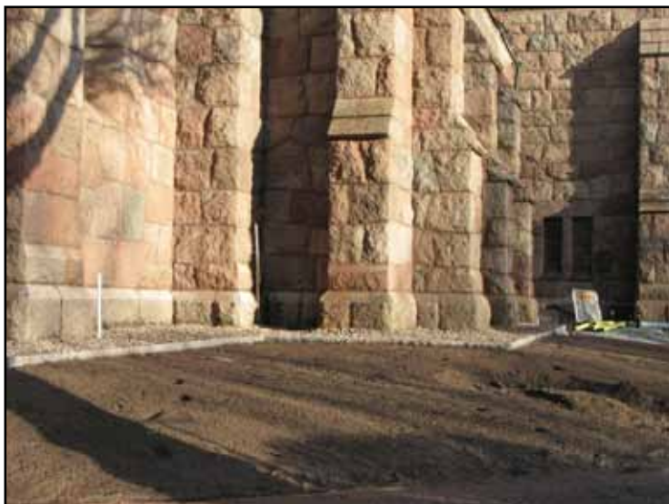
Dräneringens singelbädd med stödmur i råhuggen granit. Invid koret har ytan fått funktion som uppläggningsplats för begravningsdekorationer.
