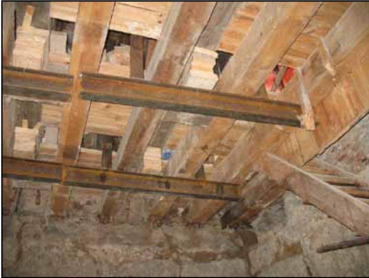
Tillfällig uppstämpling av svampangripna bjälklaget till klockvåningen inför utbyte mot stålbjälklag. Vägghugget nedhuggen.
