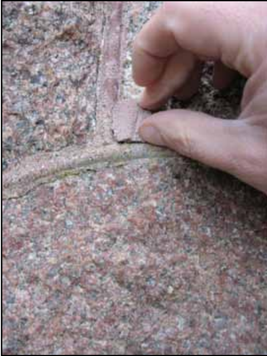
Utprovning av pigmentering för fogbruk. De nya fogarna skulle i kulör svara mot originalfogarna.
