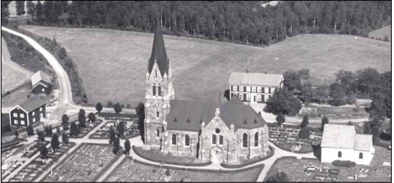
Norra Solberga gamla och nya kyrka, flygfotografi från 1935. Kyrkan har kvar sin ursprungliga taktäckning med järnplåt och de dekorativa takkuporna. JLM.
