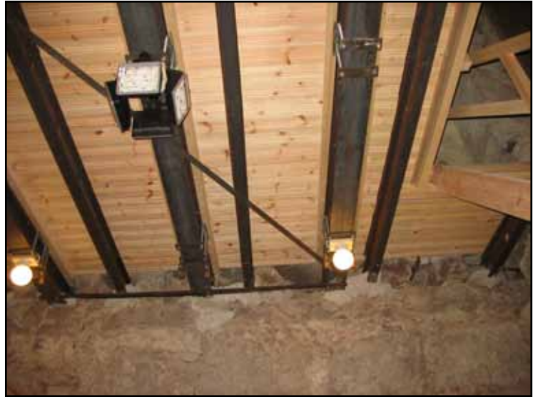
Färdigt stålbjälklag med golv inlagt.
