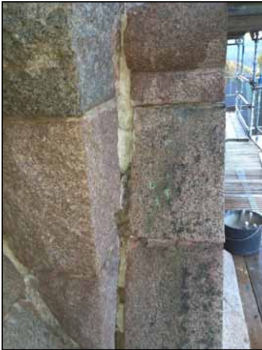
Strävpelarnas krön hade överlag mycket dåligt fäste mot muren. Pierre Nilsson, RM-Bygg visar på hur stora delar av bruket var urlakat eller bortspolat, sannolikt en av de stora källorna till vatteninträngning i tornets murverk.
