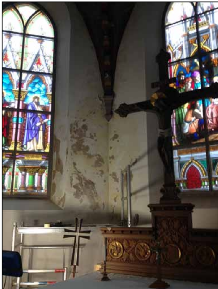
Nedhuggning av skadad puts i kor.
