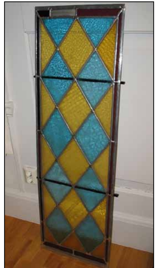
Det ena av de båda norra fönstren efter restaurering. Genomgående ny spröjsning.
